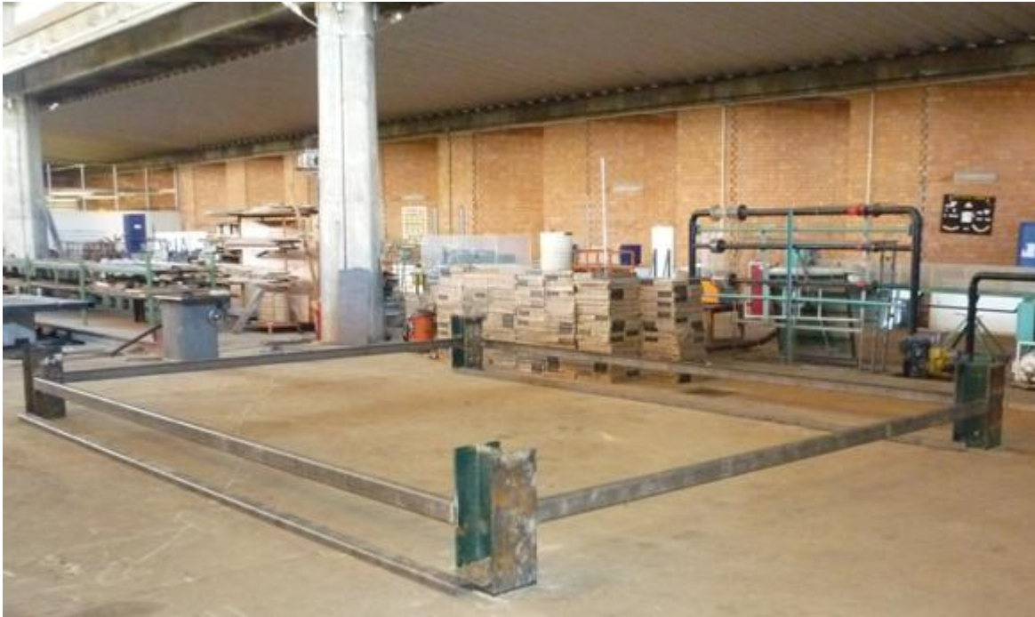
Figura 5-1. – União dos quatro pilares da plataforma de ensaios dinâmicos.
