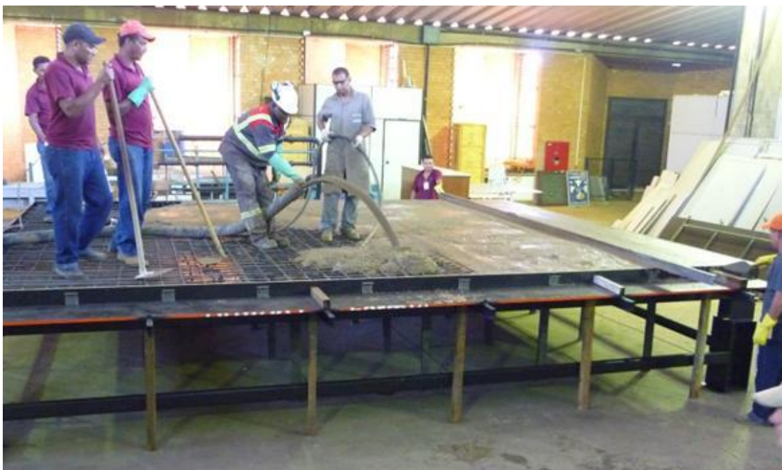
Figura 5-7. – Concreto bombeado de f_{ck} 25 MPa.
