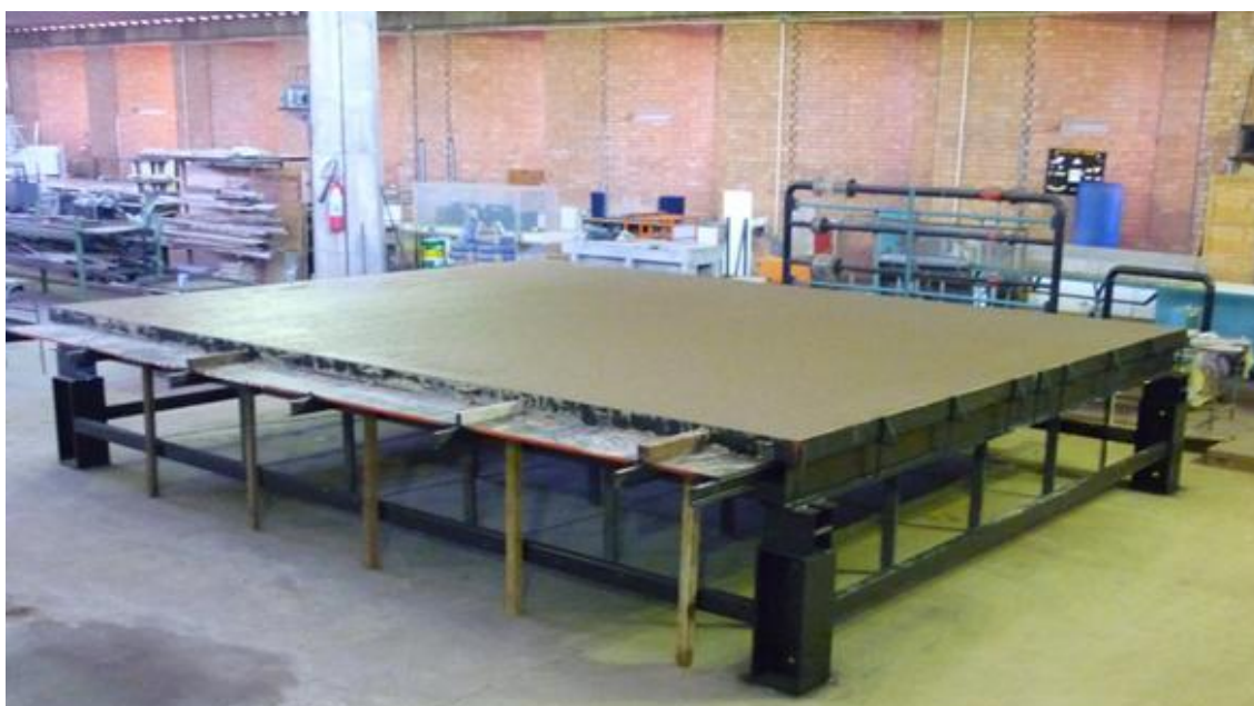
Figura 5-8. – Laje da plataforma de ensaios dinâmicos finalmente concretada.
