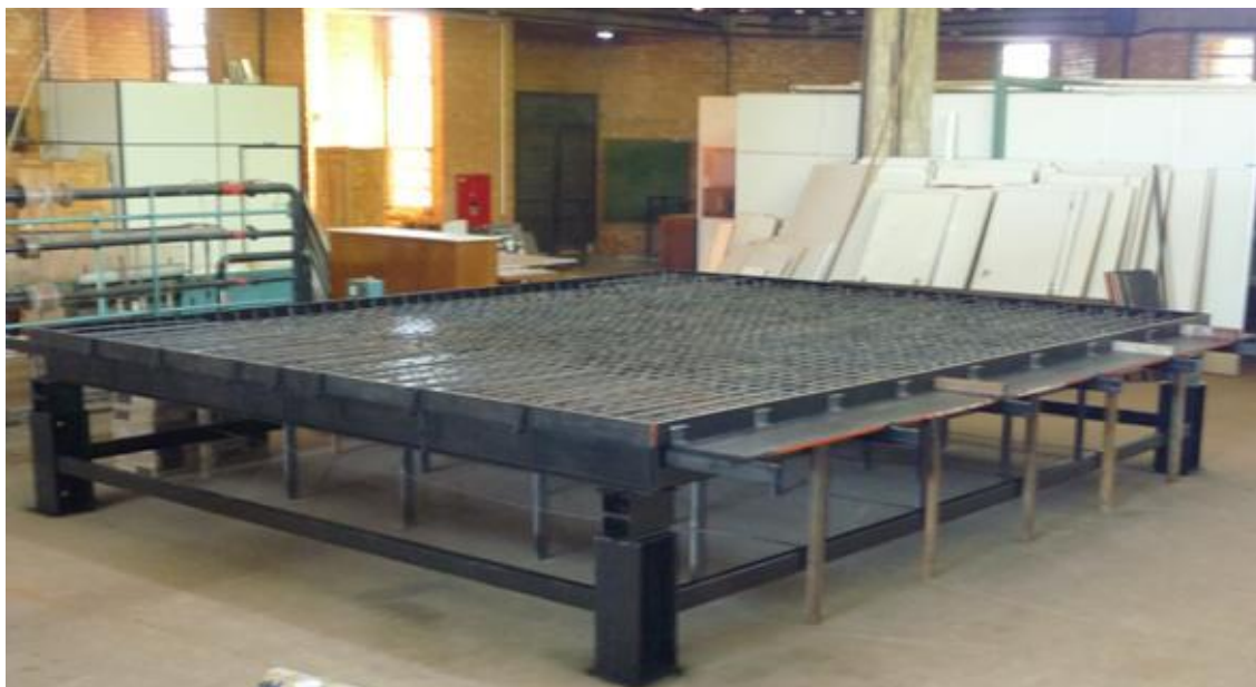
Figura 5-6. – Pintura da estrutura da plataforma, para evitar corrosão no aço.
