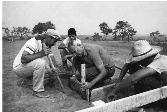
44. Lelé acompanha o alinhamento de pilares na obra de Abadiânia.
