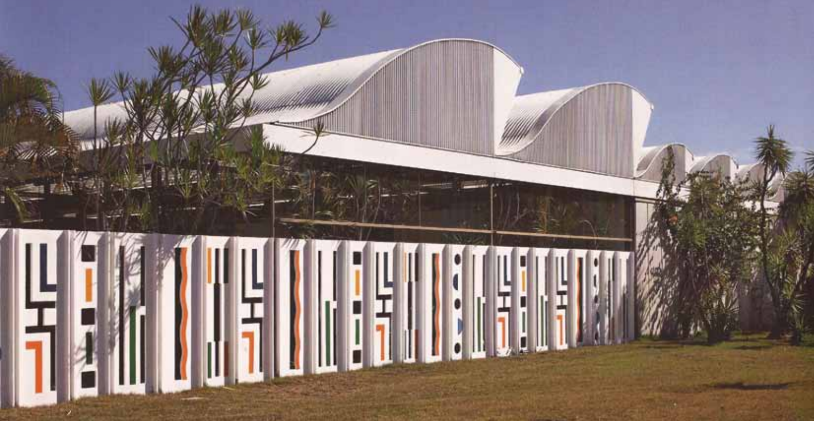
69. Hospital Sarah Kubitschek Salvador - fechamentos com painéis de Athos Bulcão. Fonte: Max Risselada (1999)
