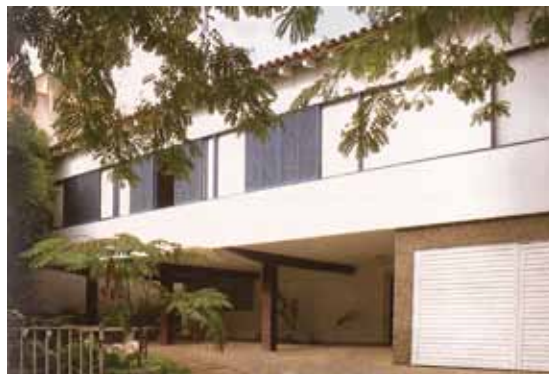
50. Residência Francisco Peixoto - Cataguases-MG Oscar Niemeyer, 1941. Fonte: Danilo Matoso (2008)
