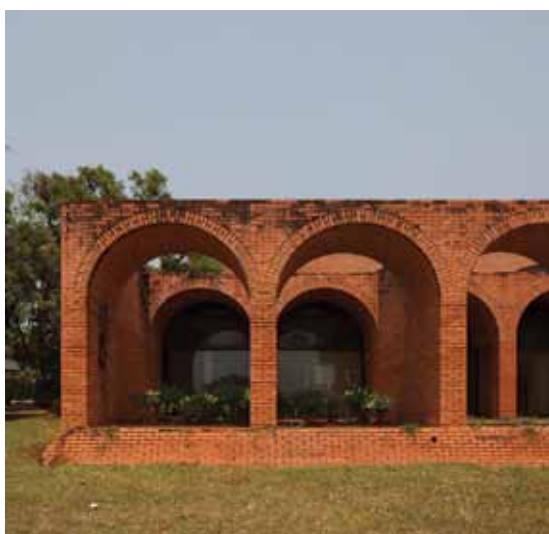
35. Residência Nivaldo Borges | módulo estrutural definido pelo vão das abóbodas. Fonte: Joana França (2011)
