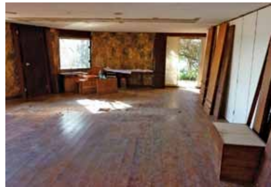
18. Residência Aloysio Campos da Paz | sala de estar em reforma. Fonte: autor (2011)
