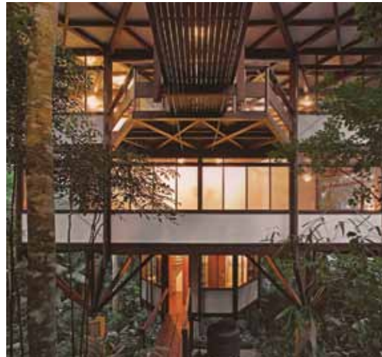
I49. Residência Marcos Acayaba - casa de veraneio Marcos Acayaba | Tijucopava, Guarujá, SP, 1996. Fonte: Marcos Acayaba (2007)
