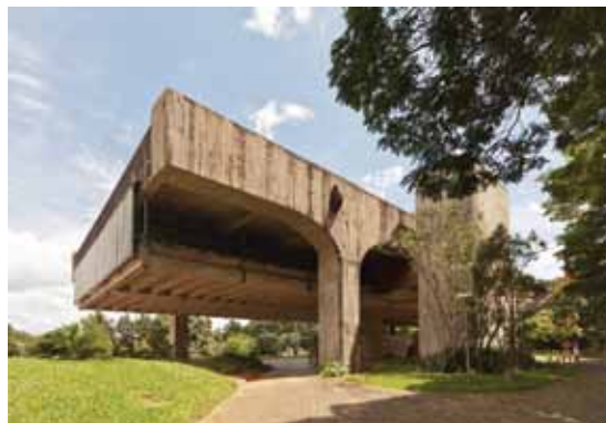
72. Residência José da Silva Netto - Lelé | Brasília, 1973 vista geral da edificação. Fonte: Joana França (2011)
