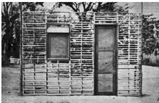
85. Painél pré-moldado em taipa empregado em Cajueiro Seco-PE | Acácio Gil Borsoi, 1965. Fonte: Ana C. de Souza Bierrenbach (2008)
