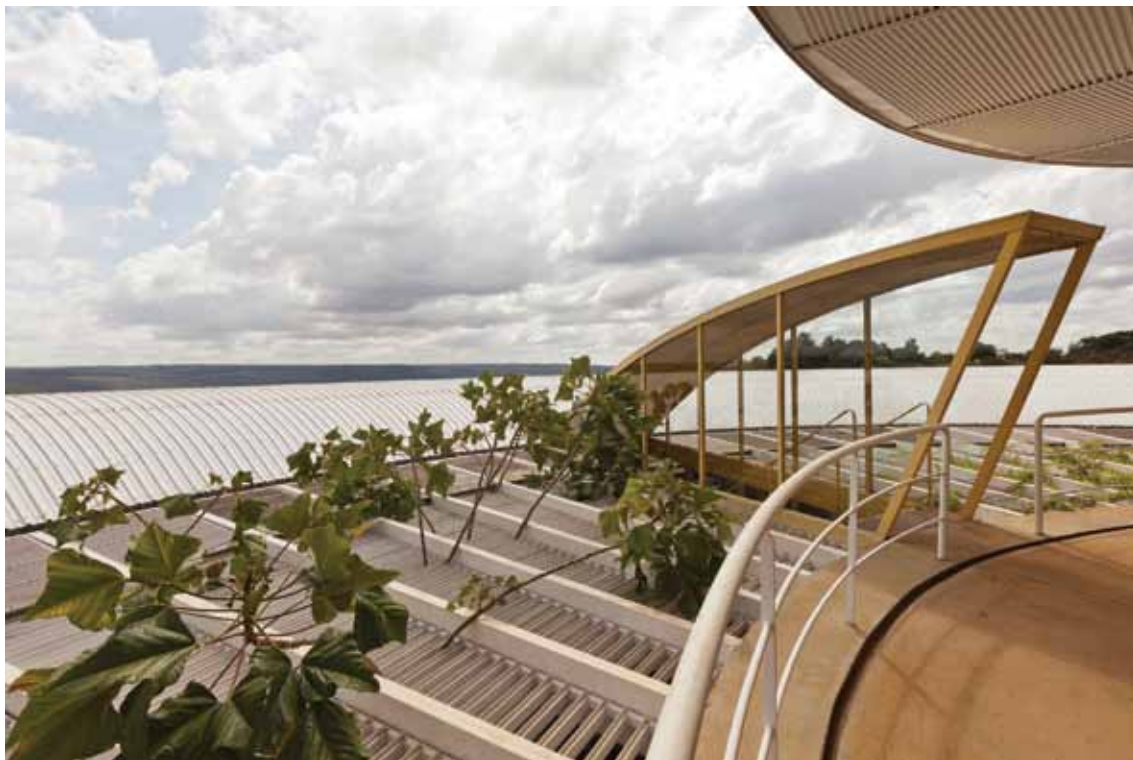
105. Residência Roberto Pinho | cobertura da escada de acesso ao interior da casa. Fonte: Joana França (2011)
