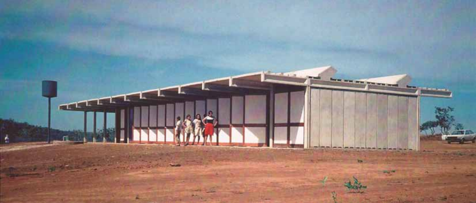
48. Escola em Abadiânia, Goiás. Fonte: Max Risselada (2010)
