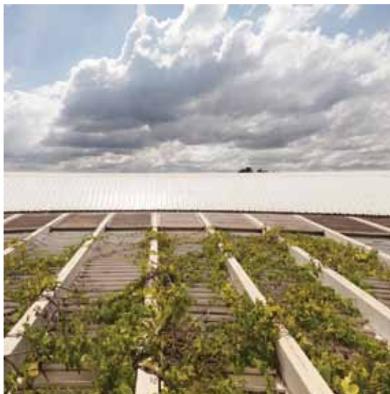
110. Residência Roberto Pinho | pérgulas radiais na continuidade das vigas treliçadas da cobertura atuam como elemento de proteção solar da fachada envidraçada no interior da residência. Fonte: Joana França (2011)
