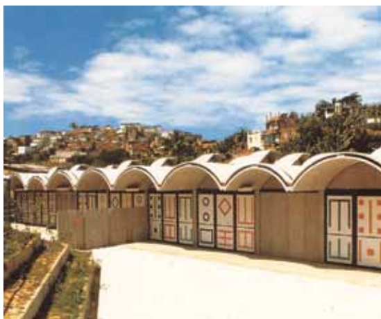
56. Creches - coberturas abobadadas. Fonte: Giancarlo Latorraca (1999)
