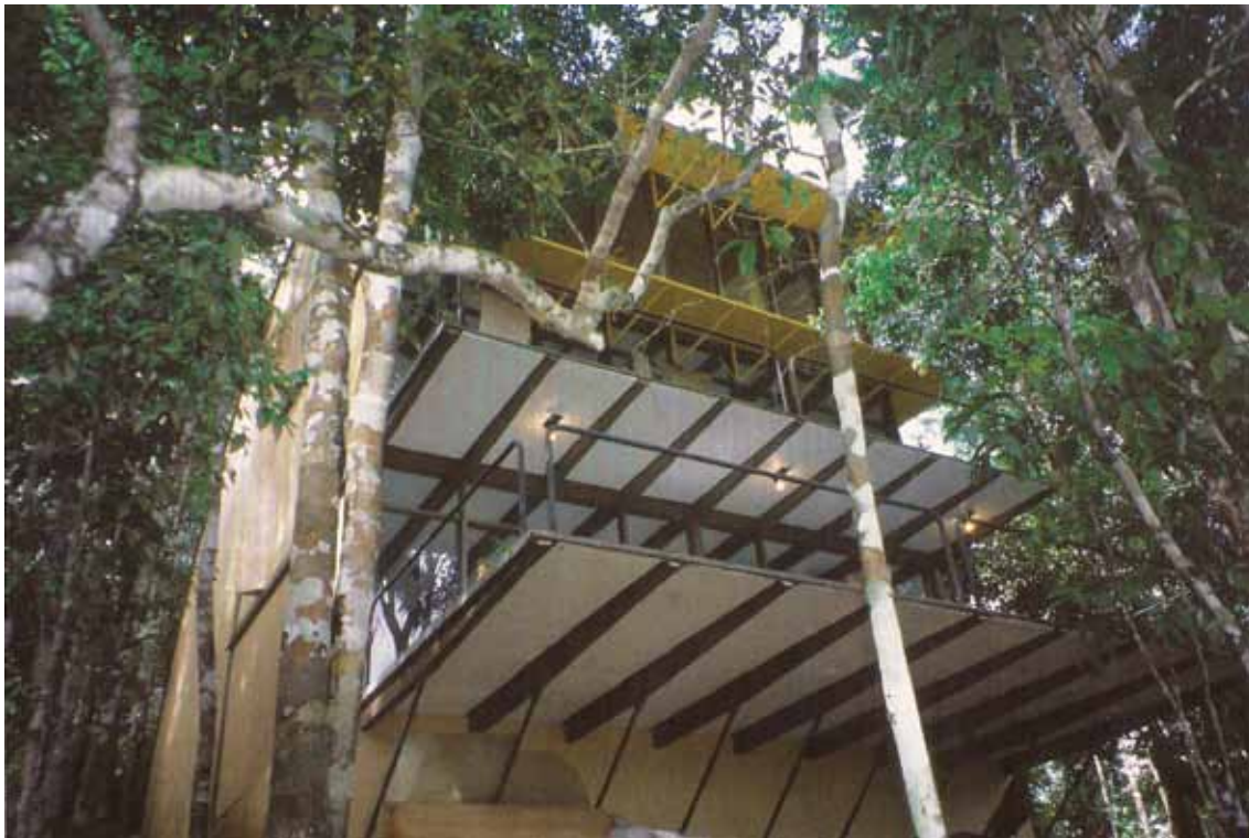
144. Res. João Santana - João Filgueiras Lima | Porto Seguro, Trancoso, 1994 | vista da casa a partir do vale. Fonte: Cláudia Estrela Porto (2010)
