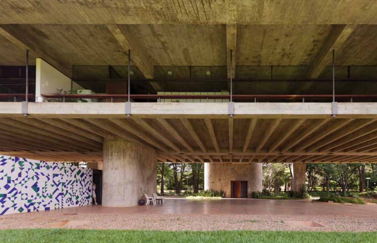
73. Residência José da Silva Netto - João Filgueiras Lima | Brasília, Lago Sul, 1973-1976. vista do pilotis com destaque para a laje do piso superior atirantada na cobertura. Fonte: Joana França (2011)
