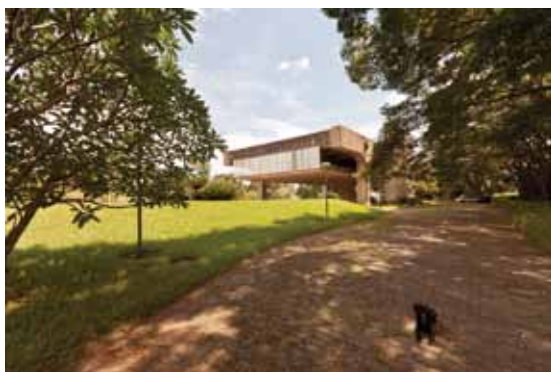
71. Residência José da Silva Netto - Lelé | Brasília, 1973 caminho de acesso à residência. Fonte: Joana França (2011)
