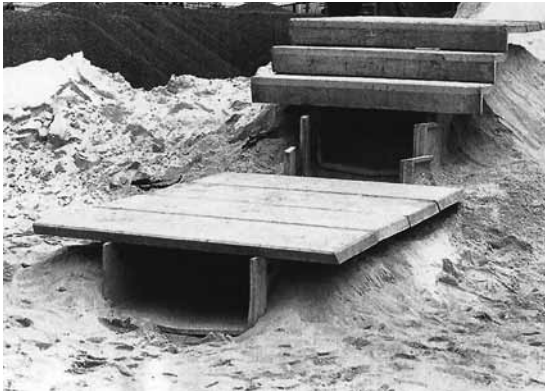
35. Escada drenante - RENURB. Fonte: Cláudia Estrela Estrela (2010)
