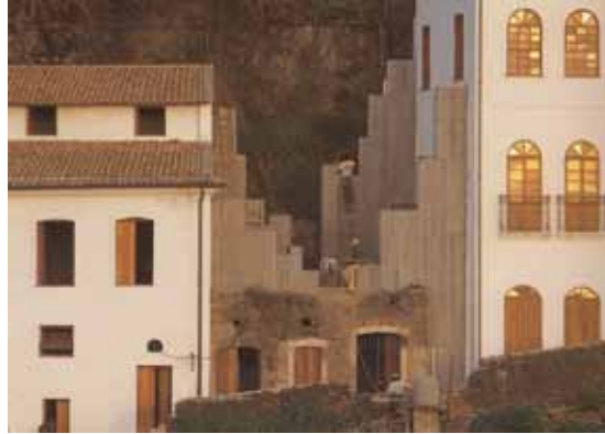
54. Ruínas dos Três Arcos e os contrafortes de estabilização. Fonte: Marcelo Ferraz (2008)
