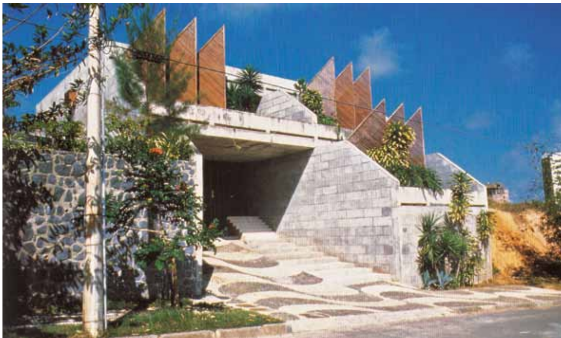
134. Residência Mário Kertész - João Filgueiras Lima | Salvador, Pituba, 1977 | fachada frontal. Fonte: Giancarlo Latorraca (1999)
