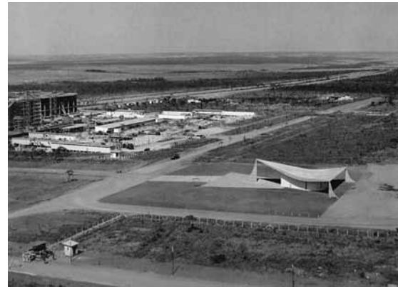
1. Superquadra 108 Sul em construção. Fonte: Lina Kim; Michael Wesely (2010)
