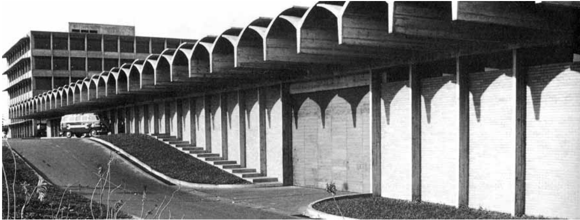
13. Concessionária DISBRAVE - bloco oficina mecânica Fonte: Giancarlo Latorraca (1999)
