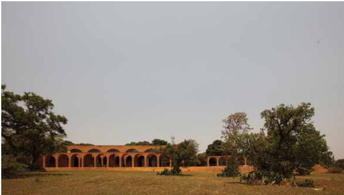
33. Residência Nivaldo Borges - João Filgueiras Lima | Brasília, Park Way, 1972-1978 | fachada (N) voltada para rua. Fonte: Joana França (2011)
