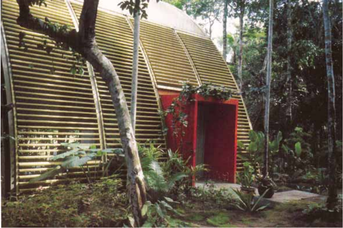
146. Residência João Santana - João Filgueiras Lima | Porto Seguro, Trancoso, 1994 | vista do pequeno pórtico de entrada pintado de vermelho. Fonte: Cláudia Estrela Porto (2010)
