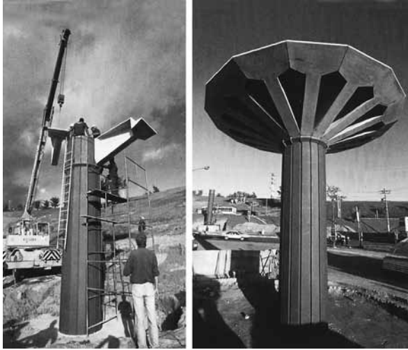
62. Passarelas FAEC - montagem do pilar. Fonte: Max Risselada (2010)
