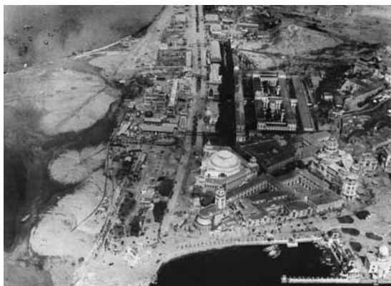
21. Vista aérea da Exposição. À direita, o Morro do Castelo sendo desmontado - Rio de Janeiro, 1922. Fonte: Skyscrapercity (2011)
