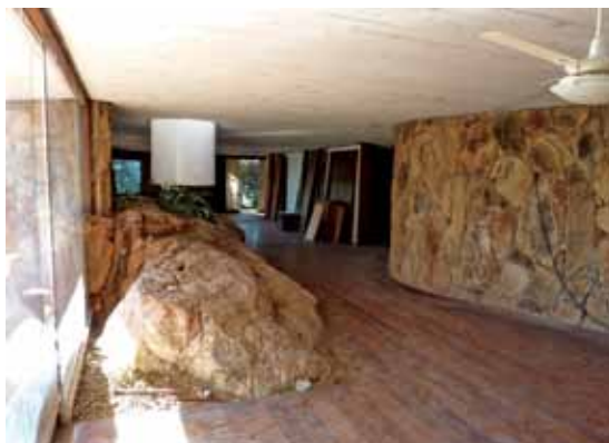
17. Residência Aloysio Campos da Paz | sala de jantar em reforma. Fonte: autor (2011)
