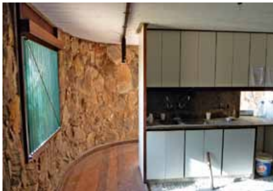
16. Residência Aloysio Campos da Paz | cozinha em reforma. Fonte: autor (2011)
