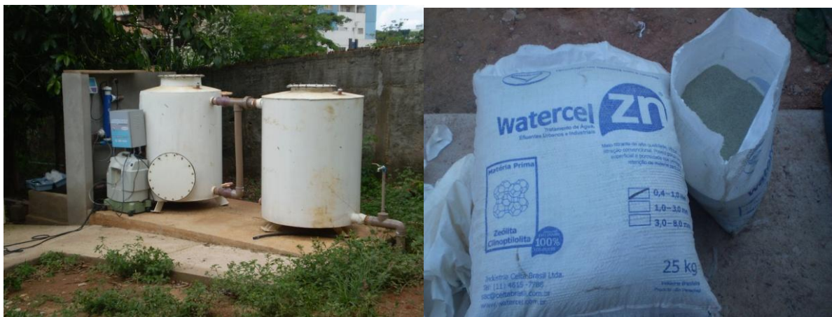
Figura 4.36 - Estação de Tratamento Simplificada - ETS, e zeólita utilizada dentre os meios filtrantes.
