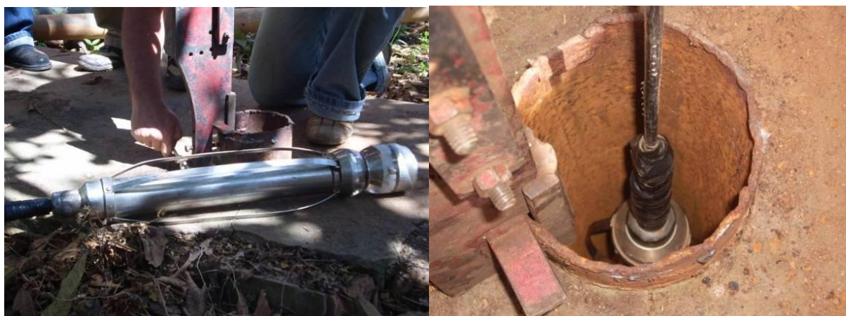
Figura 4.3 - Equipamento de Perfilagem Ótica e início de filmagem no Poço Tamburi.
