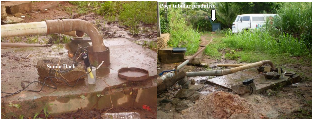
Figura 4.12 - Ensaio de infiltração no Poço Tamburi durante 79 horas contínuas. Detalhe para sonda Hach de monitoramento e poço tubular utilizado para bombeamento de água ao fundo.
