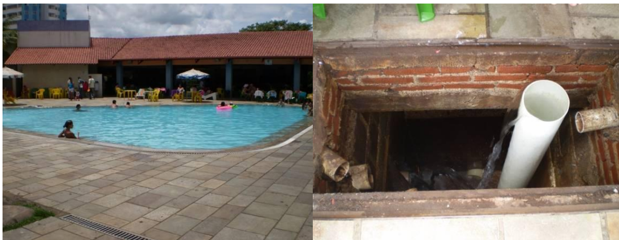
Figura 4.20 - Piscina termal e caixa de descarte de águas termais no clube CTC.
