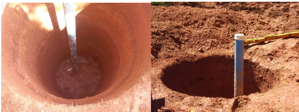
Figura 5.5 - Estação de Infiltração Experimental AMAT 2. Poço de Recarga construído em Cambissolos.
