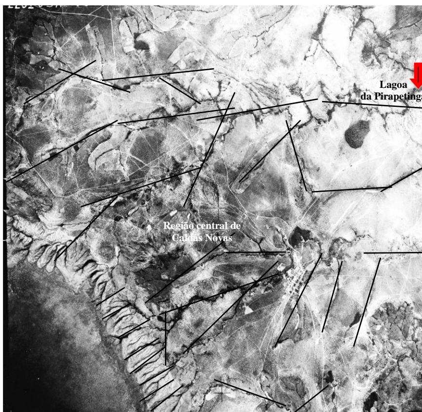
Figura 4.18 – Fotografia Aérea com principais lineamentos estruturais, evidenciando direção preferencial NE/E-W. (Fotografia USAF 1964)
