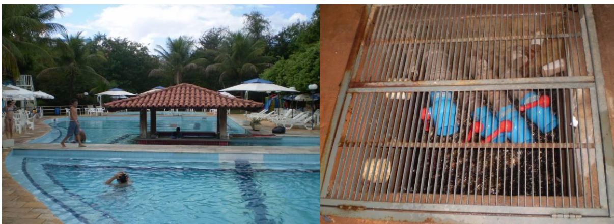
Figura 5.6 - Piscinas termais utilizadas para captação de águas, e tubulações que as conduzem ao reservatório da Pousada do Ipê.
