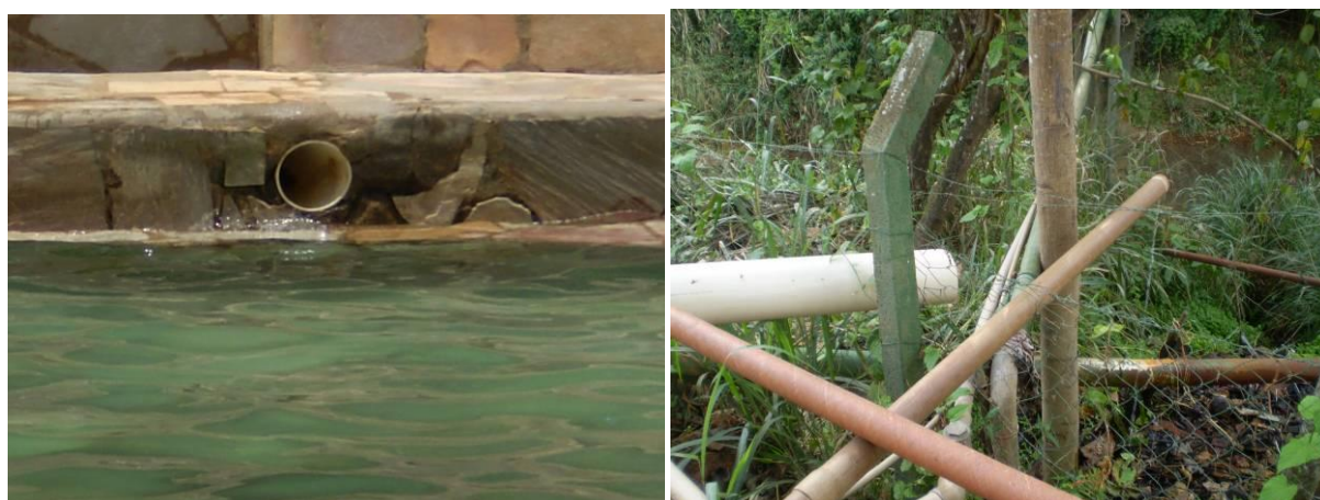
Figura 4.21 - Saída de água na parte superior da piscina termal, com descarte constante devido ao resfriamento da piscina, e lançamento direto no Ribeirão de Caldas.
