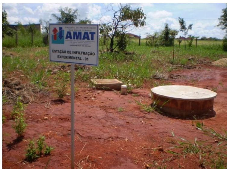
Figura 3 - Sistema de Recarga Artificial Piloto, em aquífero freático no clube Bica Pau.
