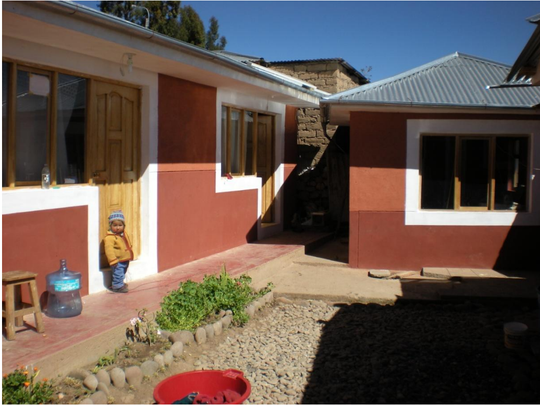
Os quartos e a cozinha moderna na frente da casa em construção.
