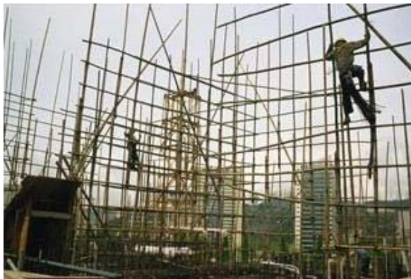
Figura 38: Andaime de bambu. Fonte: www.art.com .
