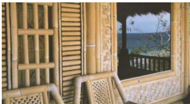
Figura 37: Fachada com diversas técnicas de vedação em bambu. Fonte: LANGLAIS, 2002, p.149.
