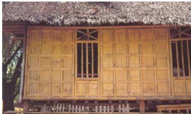
Figura 31: Casa de aldeia construída sobre pilotis em Célebes – Indonésia. Fonte: LANGLAIS, 2002, p.65.
