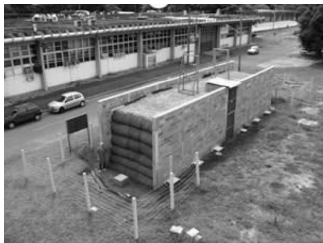
Figura 2-3. Muros 1 e 2 construídos com RCD como material de aterro (Santos, 2011)
