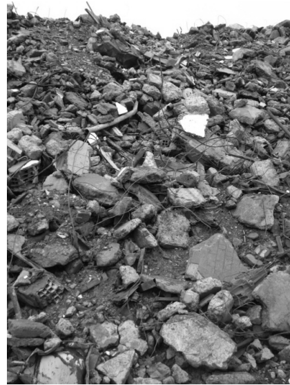
Figura 3-1. Entulho gerado pela demolição do Estádio Mané Garrincha. Pátio de armazenamento empresa Areia Bela Vista.
