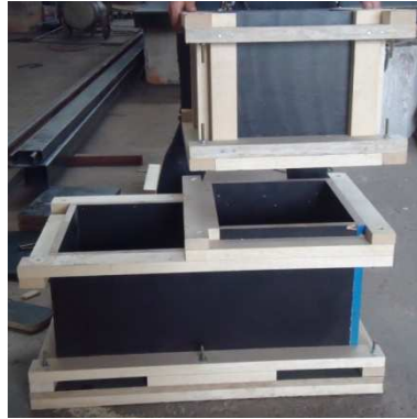
Figura 3.11 – Forma dos pilares
