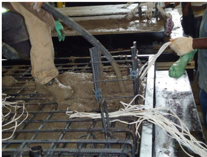
Figura 3.14 – Detalhe do adensamento do concreto
