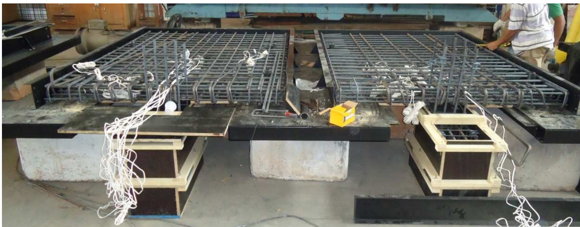
Figura 3.10 – Forma metálica após posicionamento da armadura
