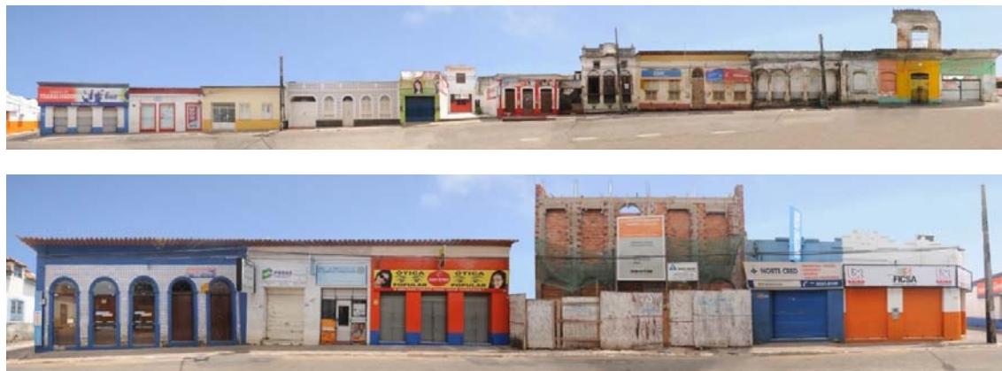
Figura 17, 18 e 19 – Rua do Sol (GOVERNO DO ESTADO, 2010).
