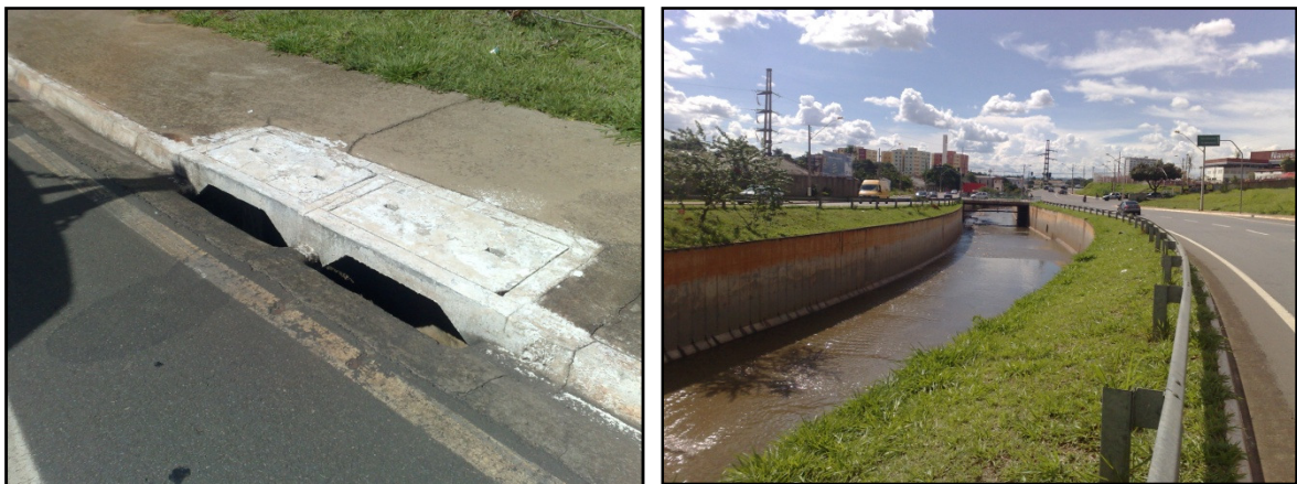
Figura 3.3. Sistemas de microdrenagem (boca-de-lobo) e macrodrenagem (canal)
