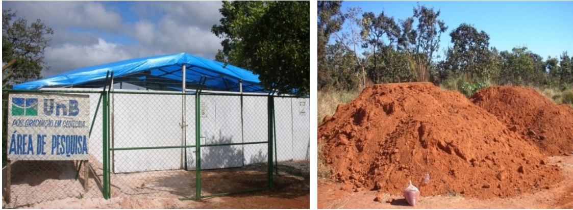
Figura 6.14 - Canteiro dos ensaios com lona azul como cobertura com solo argiloso armazenado ao lado.
