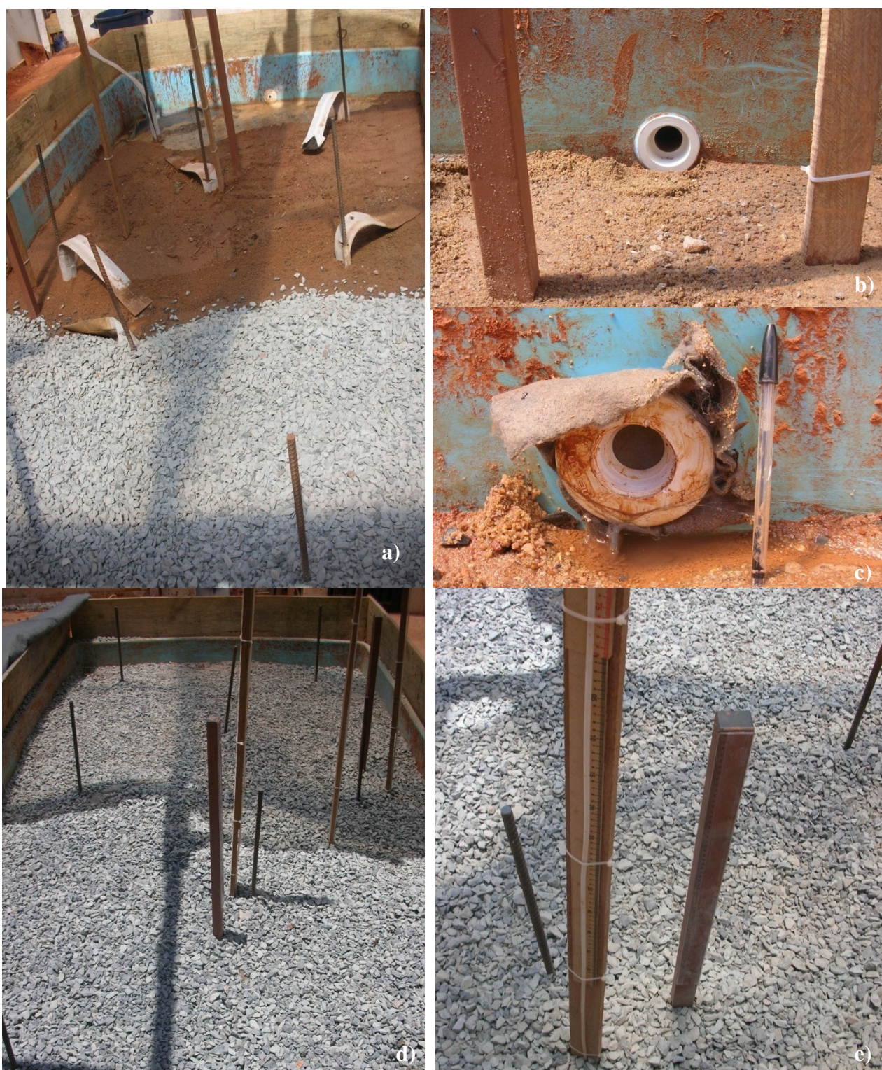
Figura 6.22 - Camadas de colchões drenantes (a e d), furo para saída de água do reservatório (b e c) e piezômetro de Casagrande e haste da placa de recalque (e).
