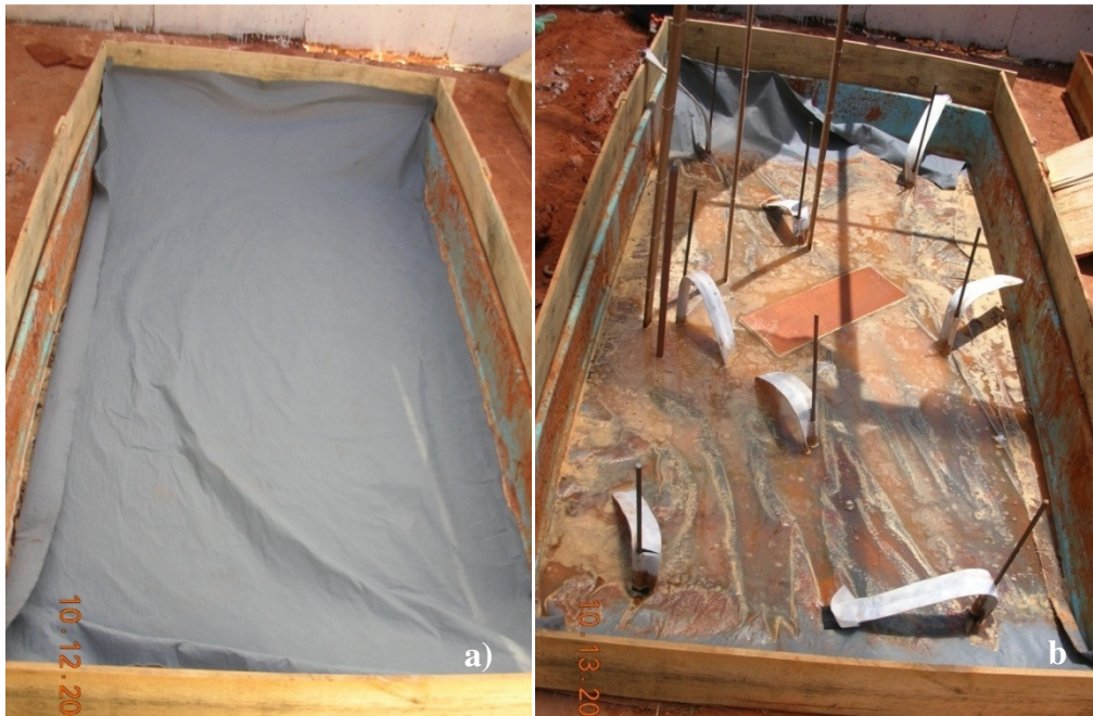
Figura 6.21 - Manta de geotêxtil sobre o solo mole (a) e drenos e instrumentação instalados (b).
