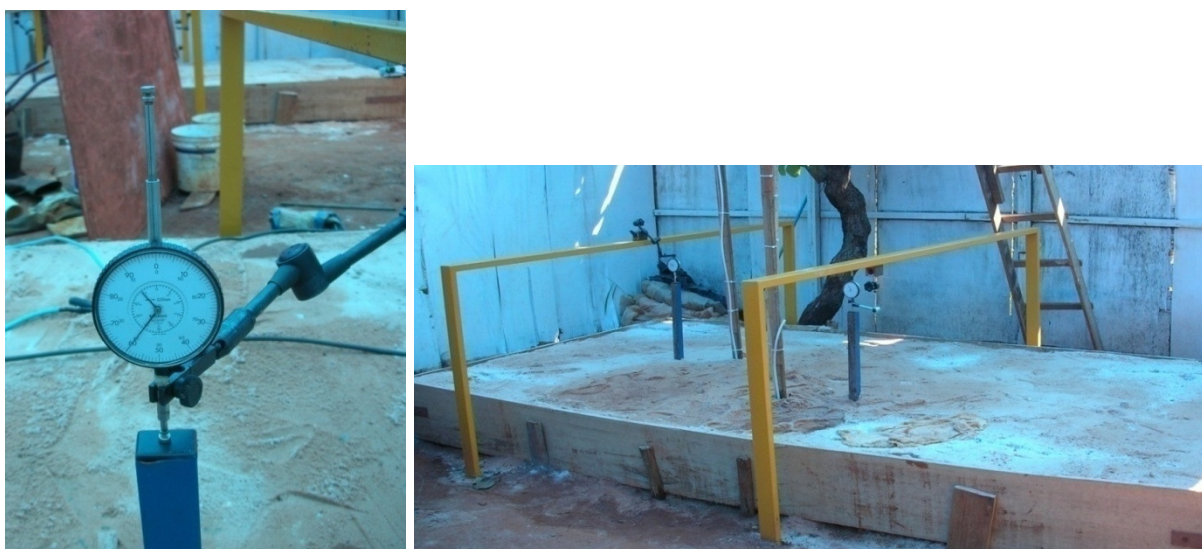
Figura 6.42 - Extensômetros e bases magnéticas imadas aos portais metálicos.
