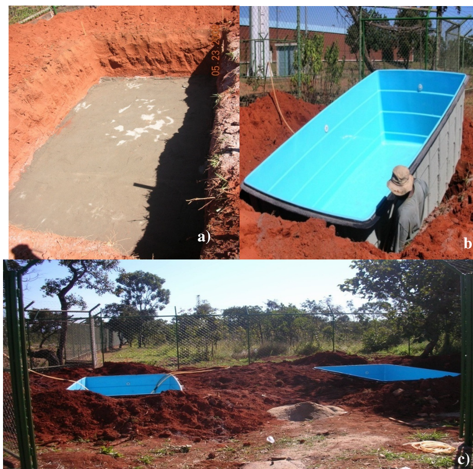
Figura 6.11 - Escavação para instalação dos reservatórios e sua devida estabilização.
