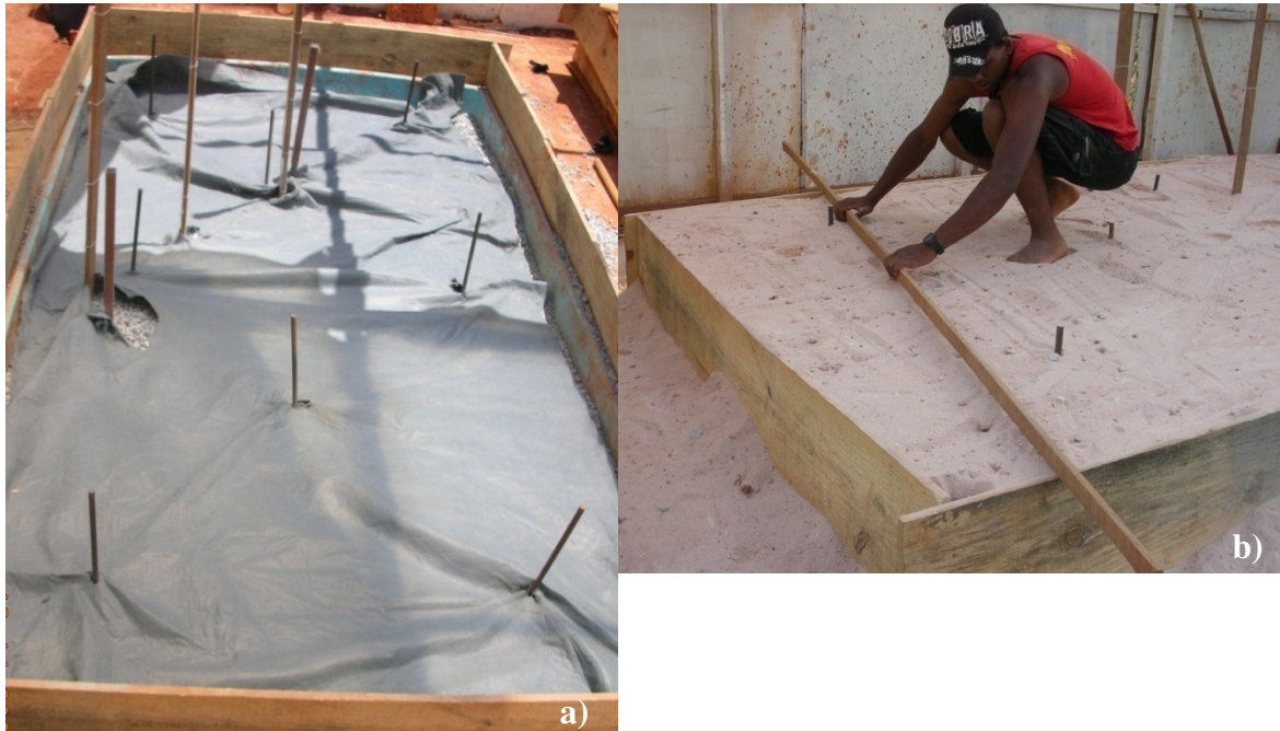
Figura 6.23 - Manta de geotêxtil sobre a brita (a) e sobrecarga de areia sendo nivelada (b).
