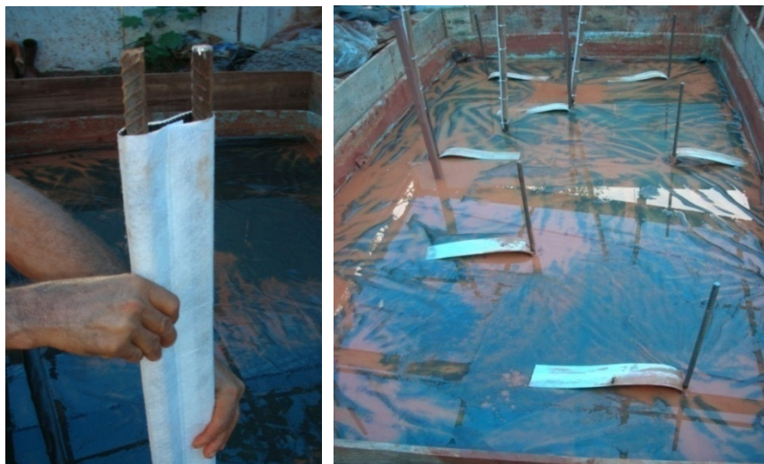
Figura 6.37 - Instalação dos drenos verticais.
