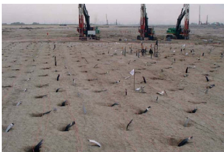
Figura 4.13 - GCE instalados com máquinas de instalação de drenos convencionais (Chew et al. , 2004).
