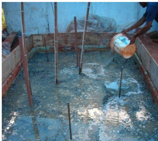
Figura 6.38 - Adicionando água para saturar a brita e garantir a saturação do solo mole.
