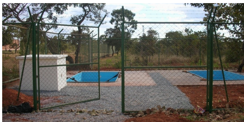
Figura 6.12 - Reservatórios com contrapiso ao redor e depósito de equipamentos e materiais.
