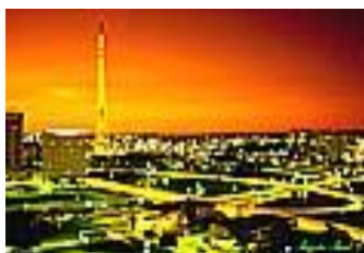
Figura 14 “Torre de TV e Setor Hoteleiro ao anoitecer” Fotografia de Augusto Areal.
