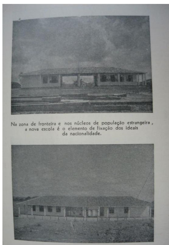
Figura 13 - Escolas construídas com recursos do Fundo Nacional de Ensino Primário. [Imagem incluída no Boletim do INEP – Ensino Primário no Brasil ; Rio de Janeiro: INEP, Boletim n. 41, 1949, p. 17.]
