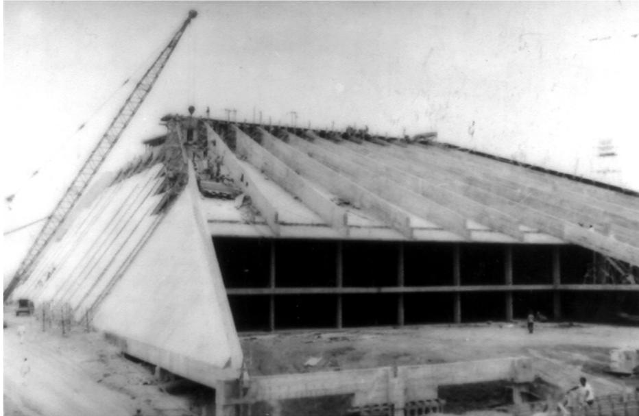
Figura 4.22: Montagem das vigas da fachada oeste (ArPDF)
