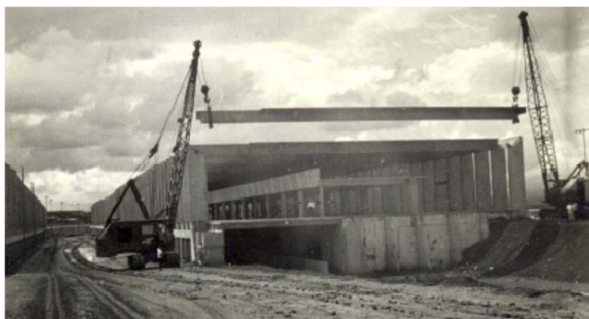
Figura 3.10: Montagem das vigas pré-moldadas da cobertura do ICC (Cedoc-UnB)
