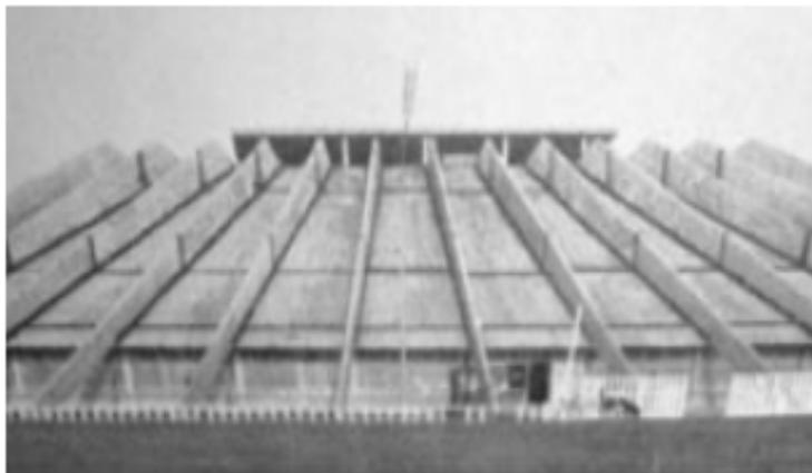
Figura 4.21: Detalhe das vigas inclinadas do foyer da Villa-Lobos (ITS/Brasília)
