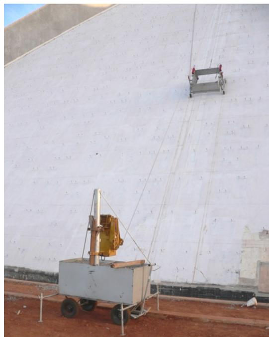
Figura 4.28: Equipamento para transporte dos novos blocos (ESTEVEVES, 2008)
