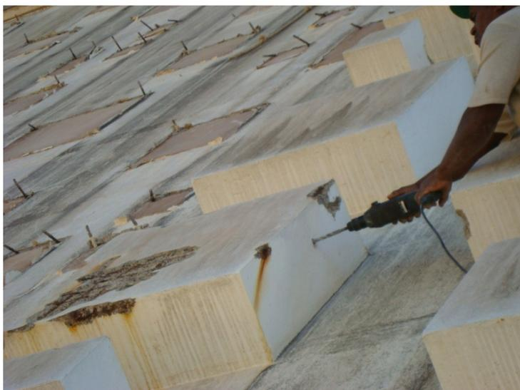
Figura 4.31: Realização de um furo no bloco na face lateral
