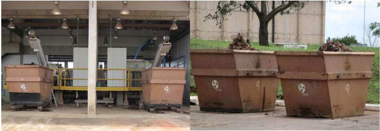
Figura 5.4. a) Saída do lodo pela rosca transportadora. b) Caçambas com lodo dispostas na ETA-Descoberto
