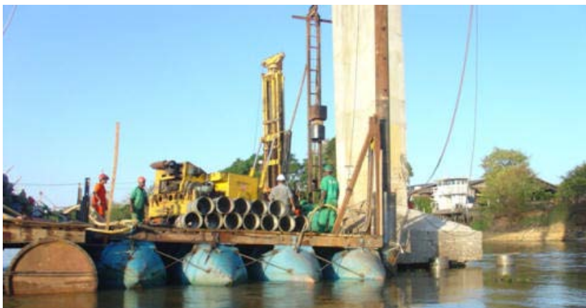
Figura 2.3 – Execução de estaca raiz no reforço de um pilar, ponte sobre o Rio Paraguai. (09.JPG, 2008).
