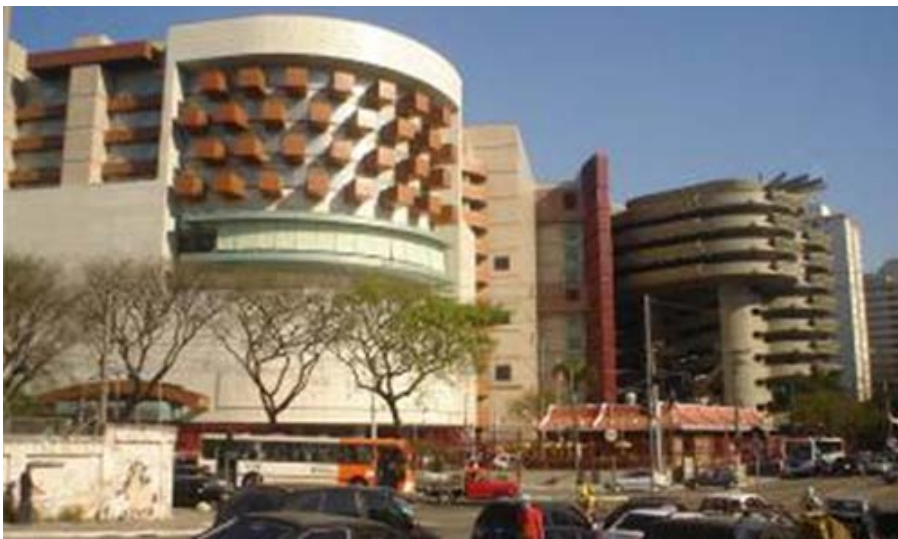
Figura 2.2 – Fachada do Shopping Bourbon Pompéia em São Paulo. (07. JPG, 2008)
