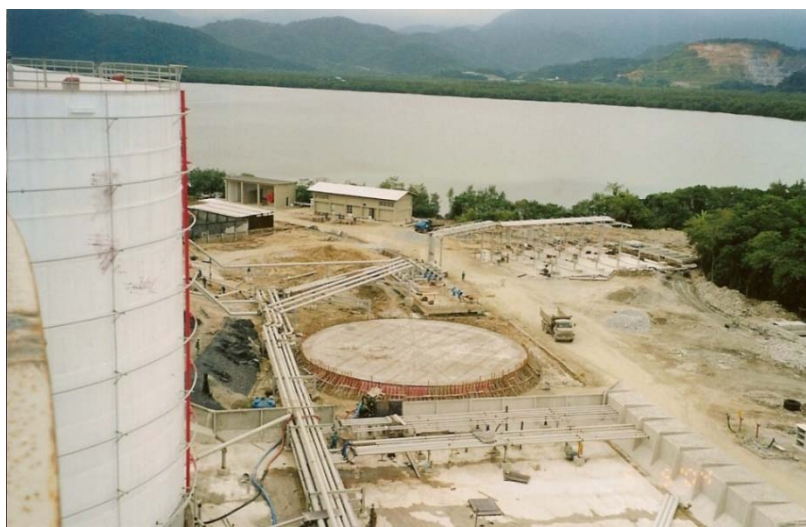
Figura 2.4 - Base de concreto armado construída para fixação dos tanques de armazenamento na COPAPE, Ilha do Barnabé.
