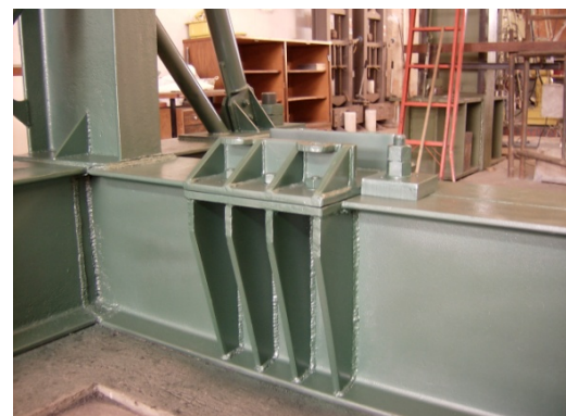
(d) – Vista da restrição inferior.
