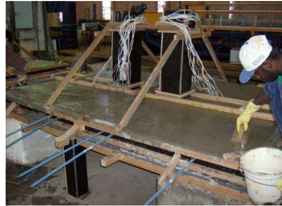
(d) – Acabamento na superfície das lajes.
