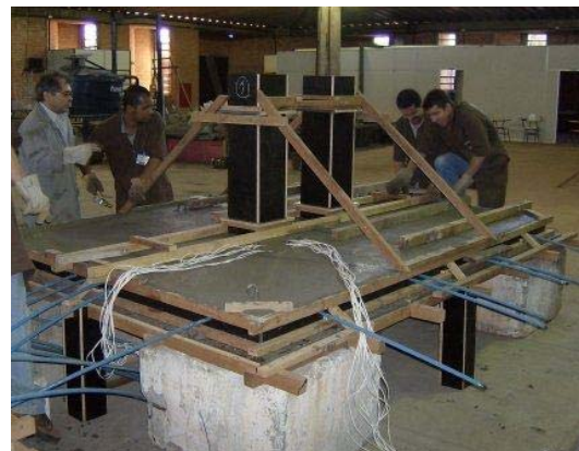
(b) – Colocação das formas superiores dos pilares
