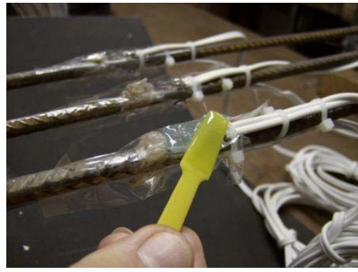
b) – Detalhe da aplicação da resina epóxi.
