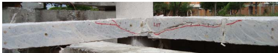
Figura 4.131 – Ruptura da laje do Modelo L07 – P1/P2 = 4,0 .
