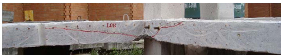
Figura 4.132 – Ruptura da laje do Modelo L08 – P1/P2 = 0,5 .
