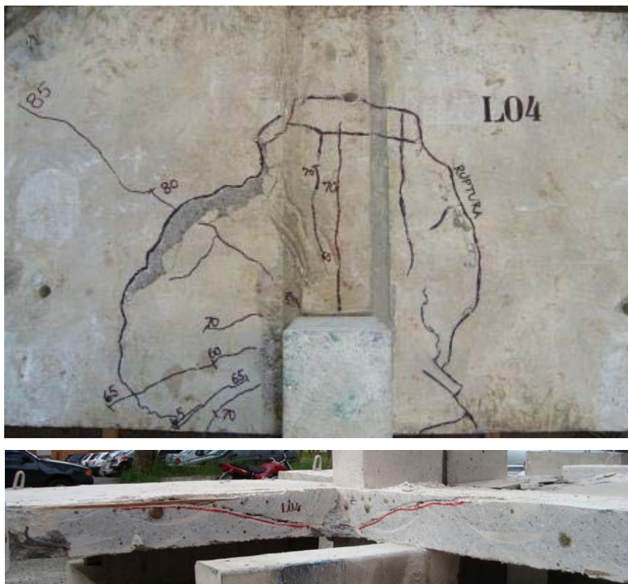
Figura 4.128 – Ruptura do da laje Modelo L04 – P1/P2 = 0,5 .
