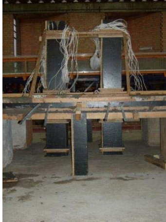
(c) – Modelos com as três etapas de concretagem concluídas.
