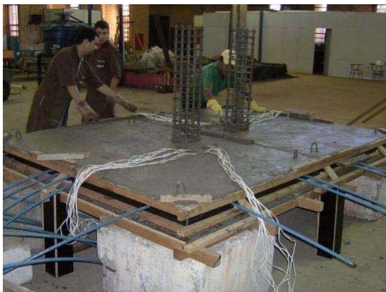
(a) – Acabamento das lajes
