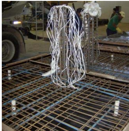
Figura 3.31 – Canos de PVC fixados nas formas.
