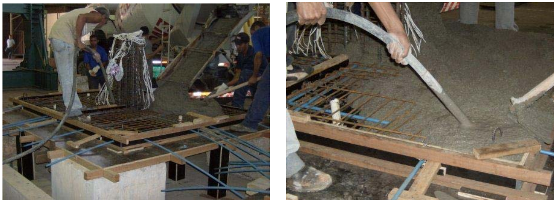
(a) – Concreto sendo lançado nas fôrmas diretamente do caminhão betoneira.
