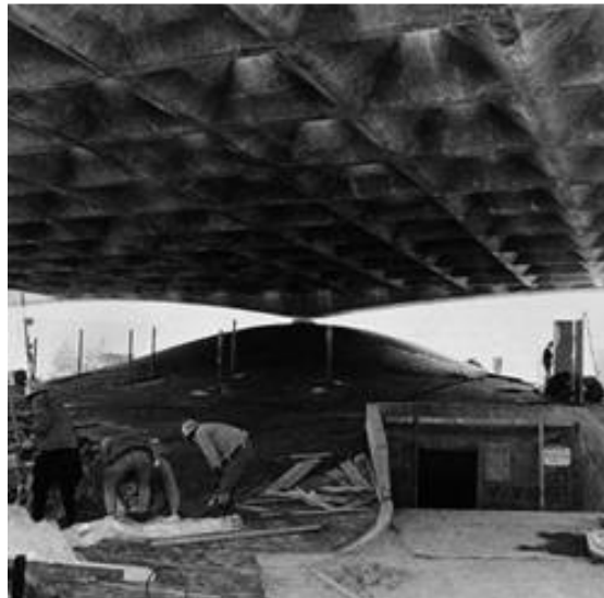
Fig. 31 – Construção Pavilhão de Osaka Fonte: ARTIGAS, 2002
