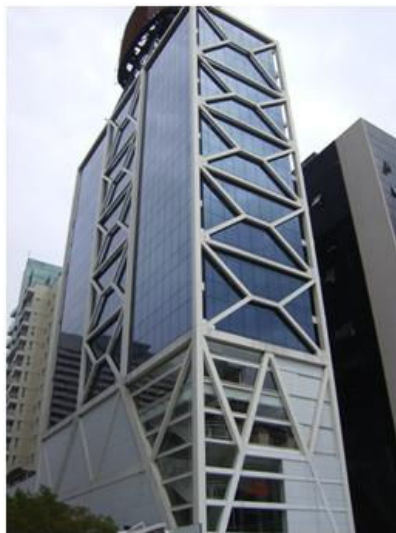
Fig. 17A - Centro Cultural Itaú - Arquiteto Ernest R. C. Mange Fonte: http://www.cbca-ibs.org.br/
