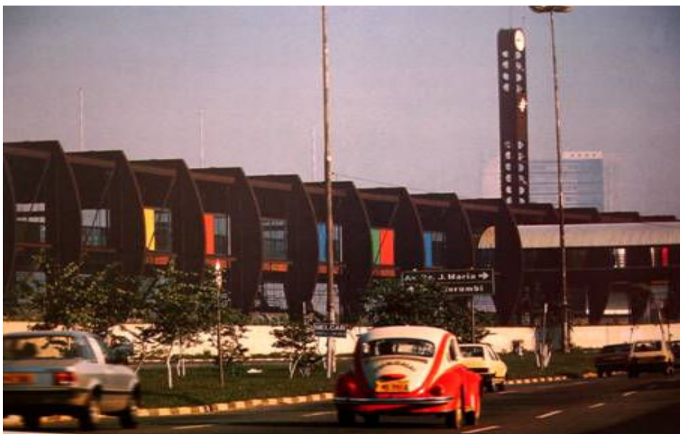
Fig. 30 – Estação Largo 13 de Maio Fonte: ARTIGAS, 2002
