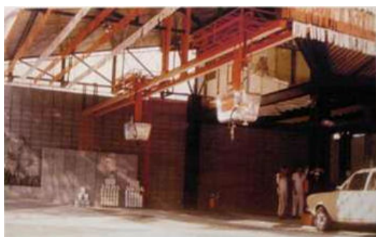
Fig. 34 – Vista Posto de Gasolina Fonte: ZANETTINI, 2002.
