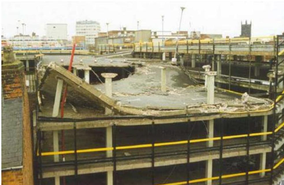
Figura 1.1 – Colapso parcial do edifício *Pipers Row Car Park*, *Wolverhampton* – Wood (1997).
