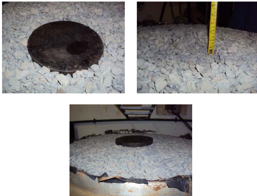
Figura 3.24 Restauração da superfície do aterro.
