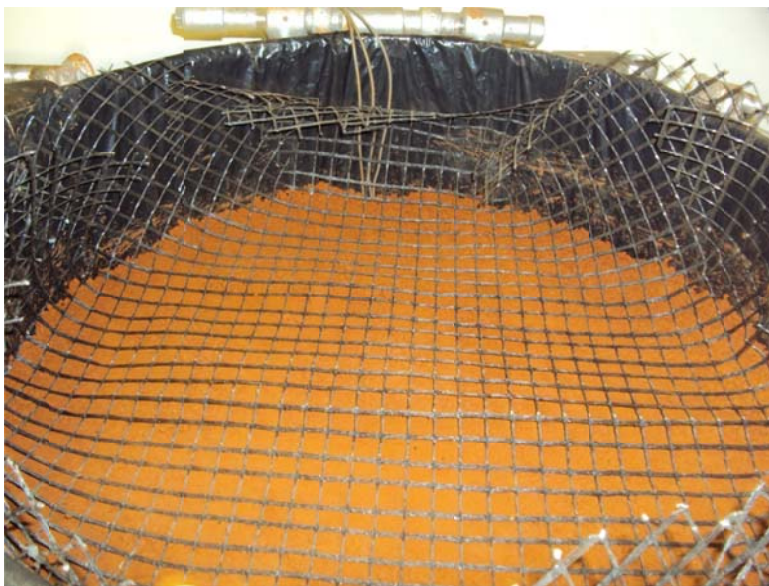
Colocação do reforço
