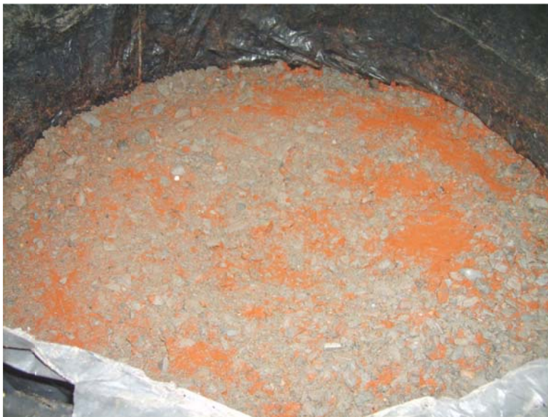
Desmontagem do ensaio (Retiro do material de aterro)
