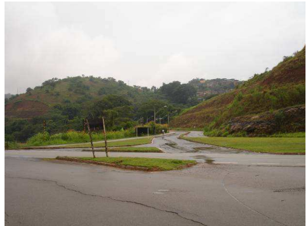
(b) Aproximação Rodovia Secundária
