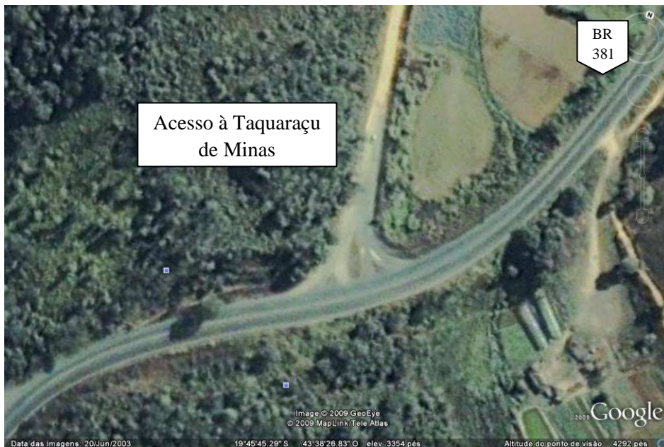
Figura 5.7: Entroncamento BR-381 – Acesso a Taquaraçu de Minas ( Google Earth )
