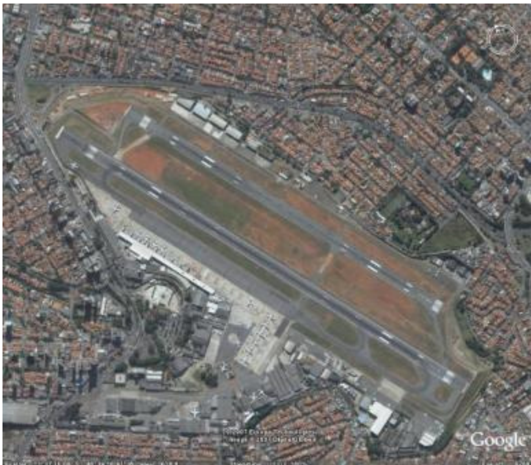
Figura 2 - Foto Aérea do Aeroporto de Congonhas em 2007.
