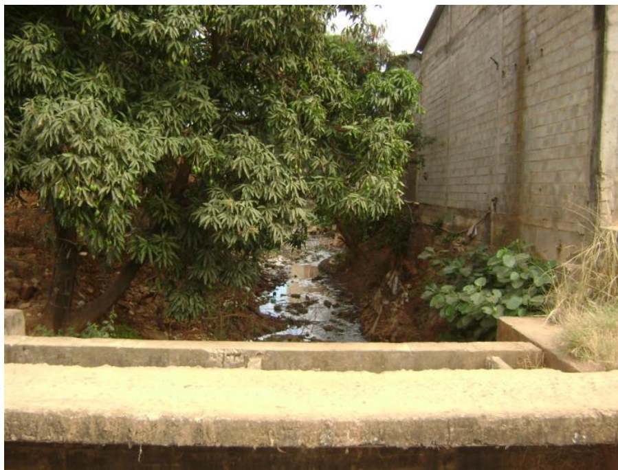
Figura 5.5 – Ocupação desordenada do solo – Construções nas margens do Rio do Antônio - jan/2009 Foto: MESSIAS, Carina – 2009
