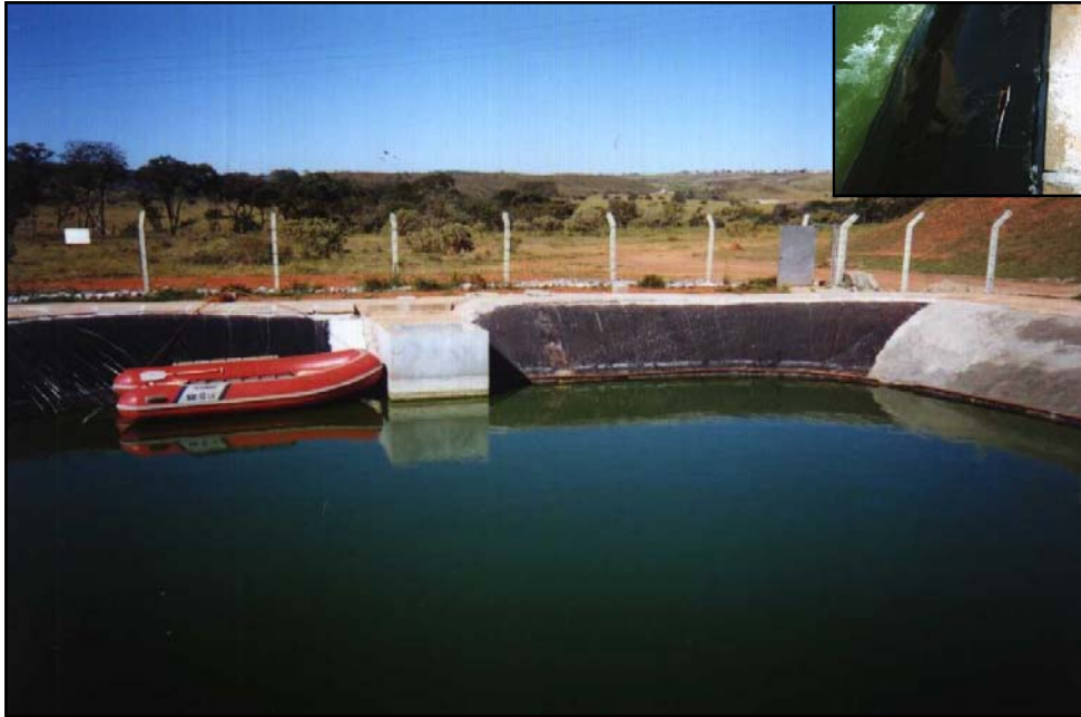
Figura 4.13 - Proteção da borda livre exposta ao sol por concreto armado. No detalhe: 1. barco inflável aportado no Monge e 2. no canto superior direito o resultado do ataque do sol à lona plástica
