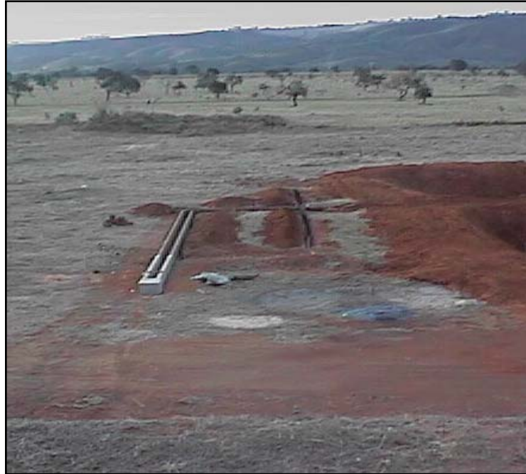
Figura 4.8 - Canal/Distribuição e tubulação afluente aos tanques (fase de acabamento - reboco)
