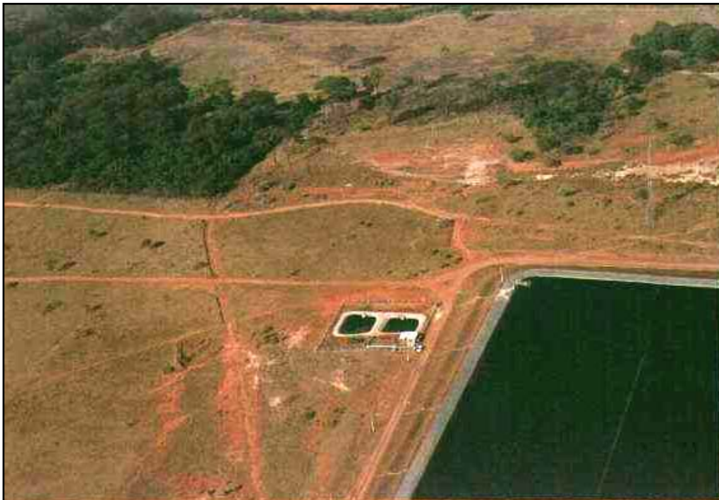
Figura 4.2 - Fotografia Panorâmica da Unidade Piloto de Samambaia (parte da lagoa de polimento final do módulo II da ETE pode ser vista do lado direito)
