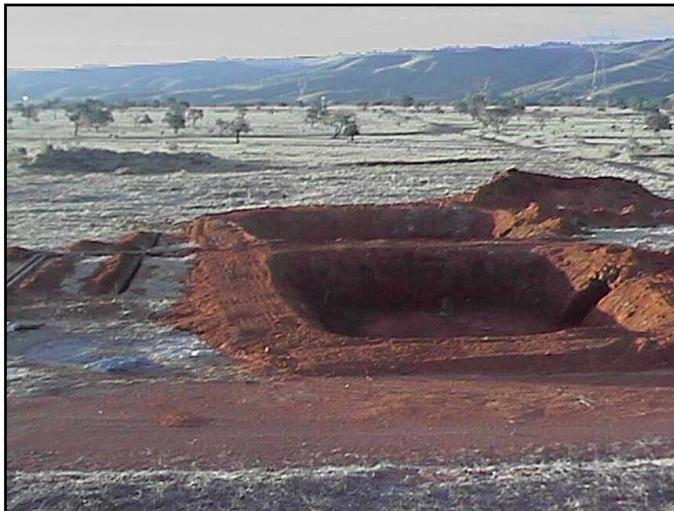
Figura 4.7 - Tanques Piscícolas (Fase de acabamento da terraplanagem) tanque 1 em primeiro plano e ao fundo o 2
