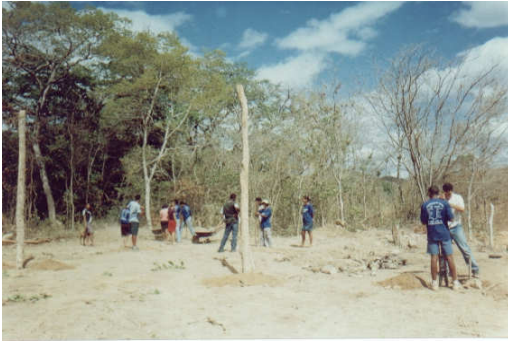
Início da construção do Barracão dos Formandos - 2002
