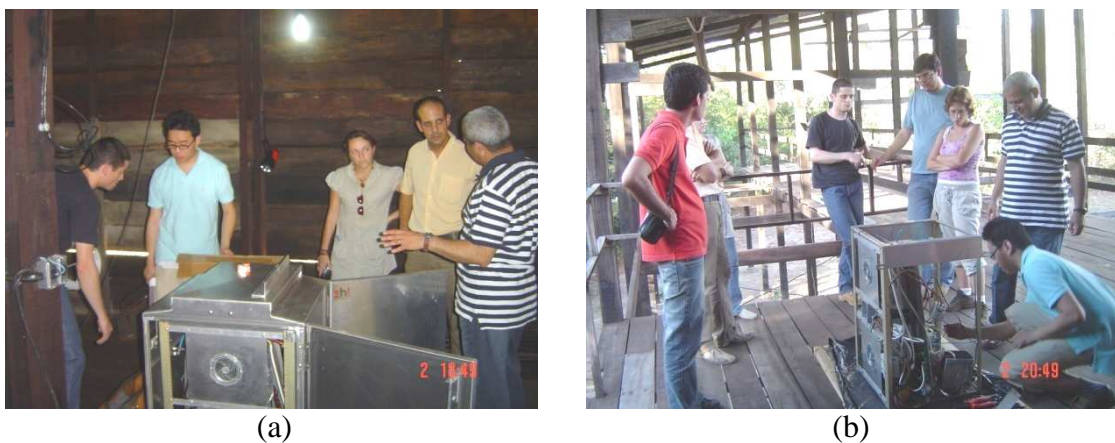
Figura 4.4 Treinamento e instalação do eletrolisador.
