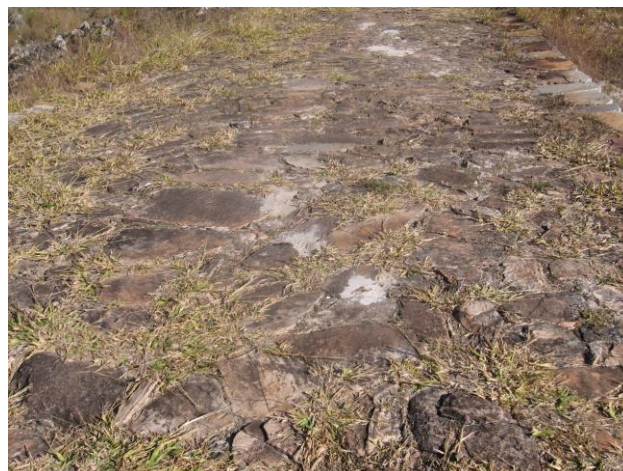
Foto 8: Trecho do caminho dos escravos, remanescente da Estrada Real Fonte: Pesquisa do autor (2008)
