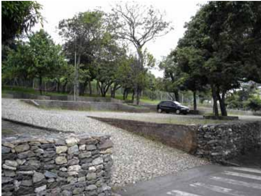
Figura 9. Aspecto da área de estacionamento. Destaque para o revestimento. Foto do autor (fev/2007).
