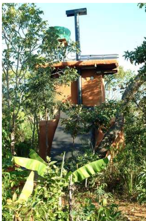
Foto 9 – Vista do exterior do sanitário compostável da Chácara Asa Branca. Fonte: www.chacaraasabranca.org.br
