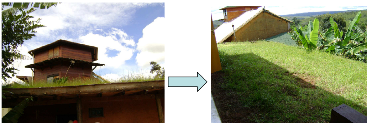
Foto 6 – Telhado jardim – Sítio Tamanduá
