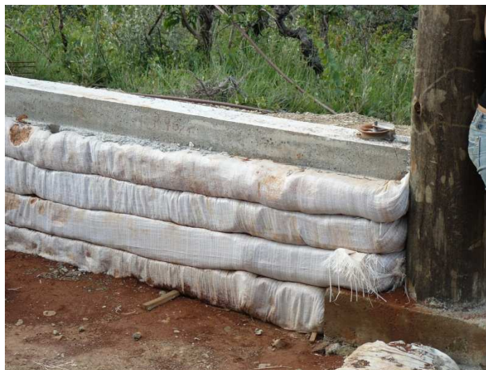
Foto 3 – Fundação de concreto e sacos de areia
