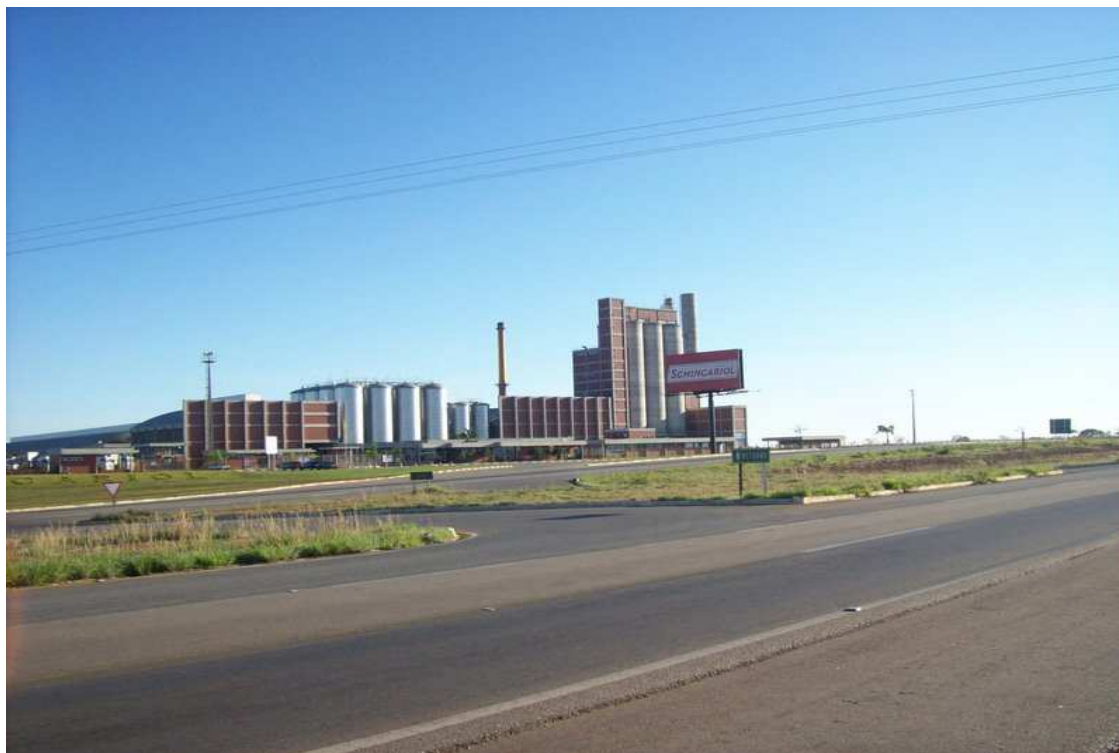
Figura 6: Vista da Indústria Schincariol em Alexânia
