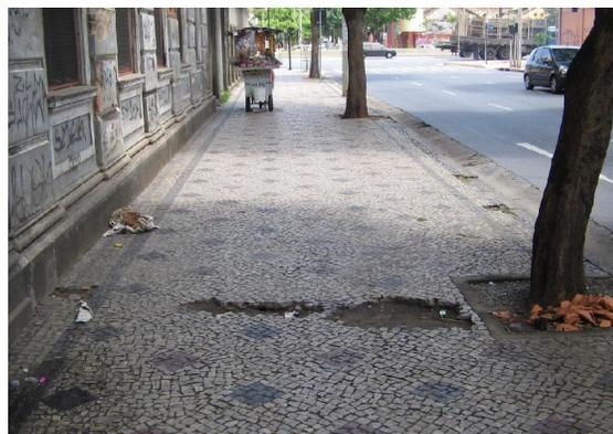
**Figura 5.5:** Falta de Manutenção nas Calçadas
