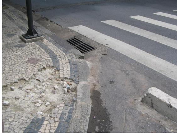
**Figura 5.2:** Ausência de Rampa para Pessoas com Mobilidade Reduzida
