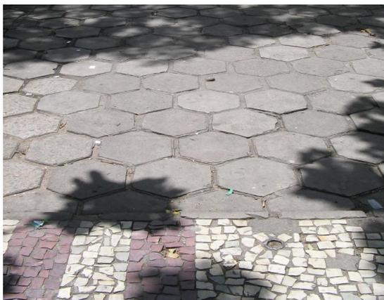
**Figura 5.7:** Mudança de Revestimento sem Sinalização para Deficientes Visuais
