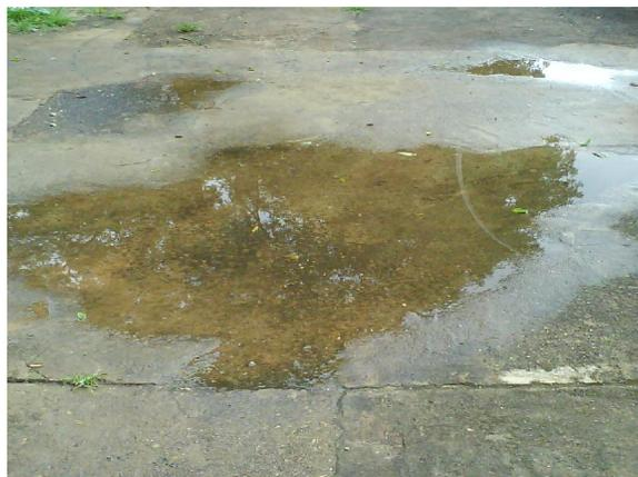
**Figura 5.4:** Formação de Poças de Água na Calçada
