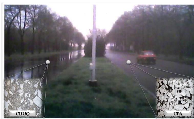
Figura 2.11. Comportamento de duas vias uma feita com um revestimento drenante (CPA) e uma com revestimento fechado (CBUQ) (Modificado de Reis & Santo, 1999)
