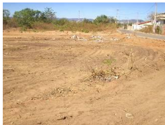
FIGURA 56: Uso de máquinas pesadas na limpeza APM -19 (A.V.N.A) ARSO 22, nov, 2007.
