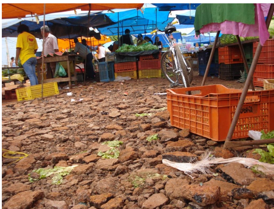
Figura 13. Aspecto da pavimentação provisória da Feira, em setembro de 2009.
