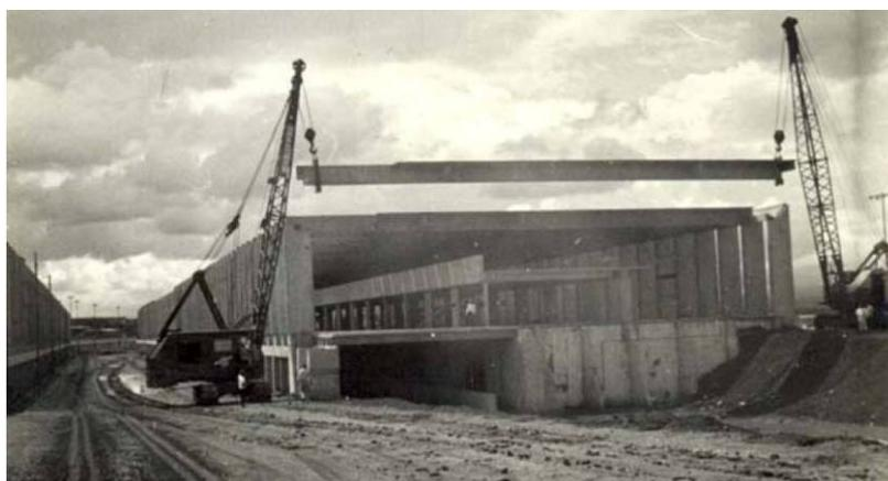
Figura 48: Montagem das vigas pré-moldadas da cobertura do ICC. Fonte: FONSECA, Regis, 2007, p. 6.
