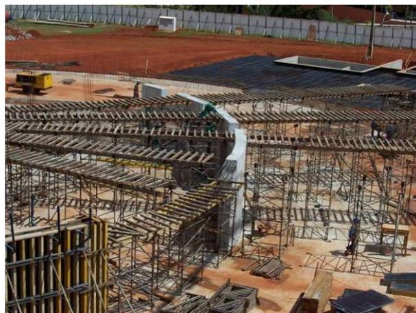
Figura 62: Escoramento das Vigas Radiais. Fonte: VIA Engenharia.
