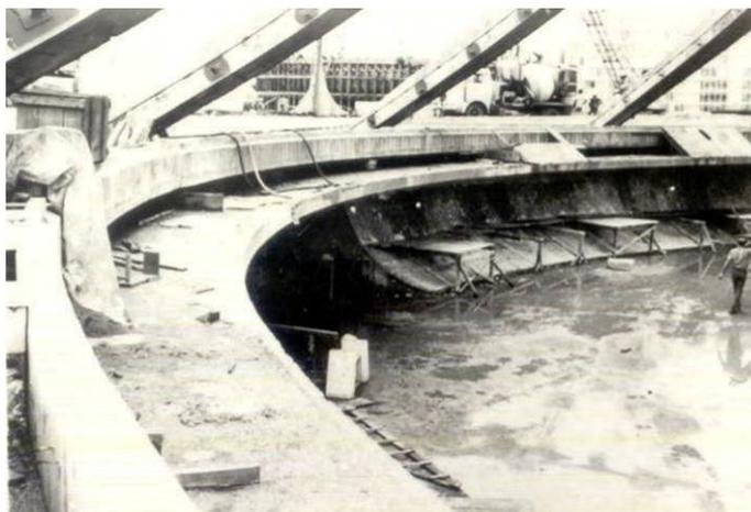
Figura 39: Detalhe da construção do anel de tração na base da Catedral de Brasília, 1959. Fonte: Arquivo Público do DF.
