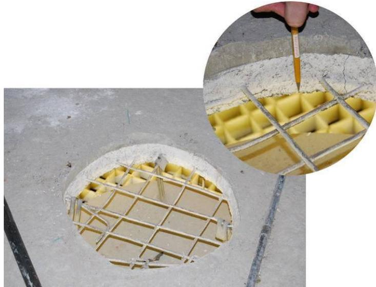
Figura 136: Furo na laje forro para instalação de luminárias, no detalhe a espessura. Fotos do autor.
