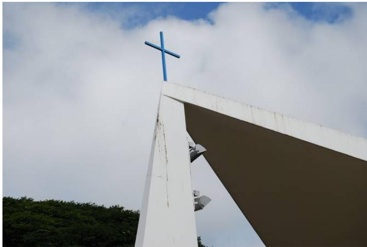
Figura 105: Detalhe do encontro do Pilar principal com a cobertura. Foto do autor.
