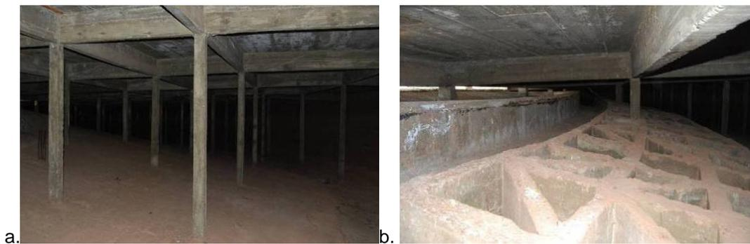
Figura 139: a. Pilares entre terceira casca e a laje superior. b. Aberturas na terceira casca que permitem uma excelente ventilação. Fotos do autor.
