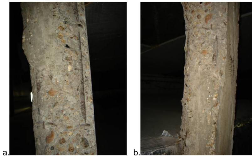
Figura 138: Detalhes dos pilares. O desgaste do concreto evidencia a grande quantidade de ferro utilizado. Fotos do autor.
