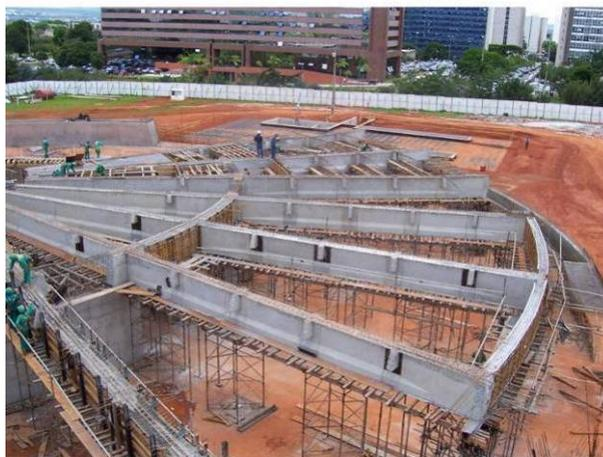
Figura 63: Vigas Radiais concretadas. Fonte: VIA Engenharia.
