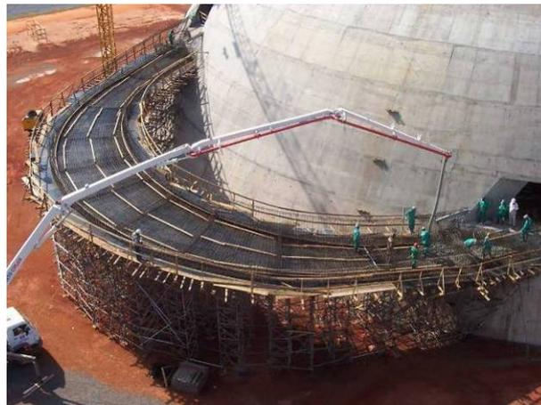
Figura 71: Concretagem da Rampa 3. Fonte: VIA Engenharia.
