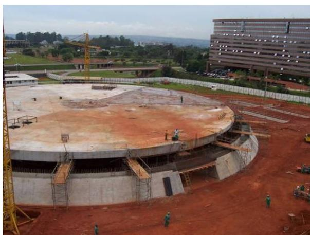
Figura 64: Laje do pavimento de exposições concretada. Fonte: VIA Engenharia.
