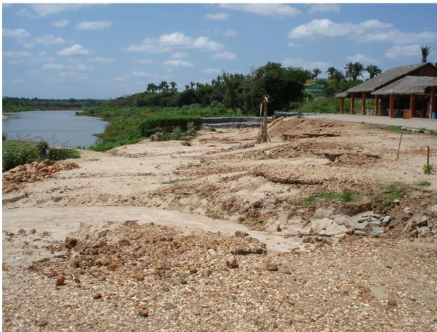
Figura 130: Os muros de arrimo foram destruídos pela enchente, 2008.
