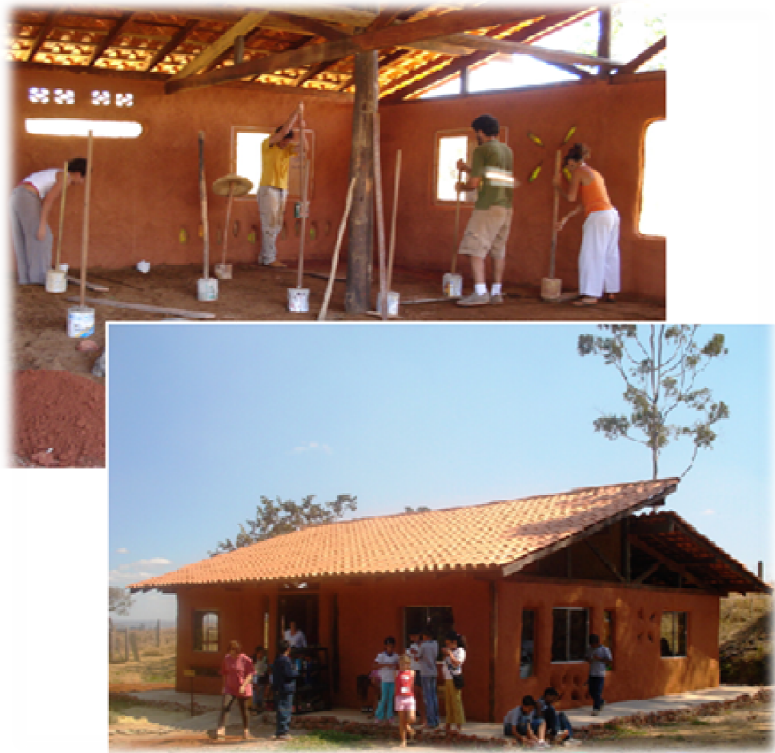
Figura 8 Finalização da construção da Ecoteca. Fonte: fotos do acervo do Projeto Sombra da Mata
