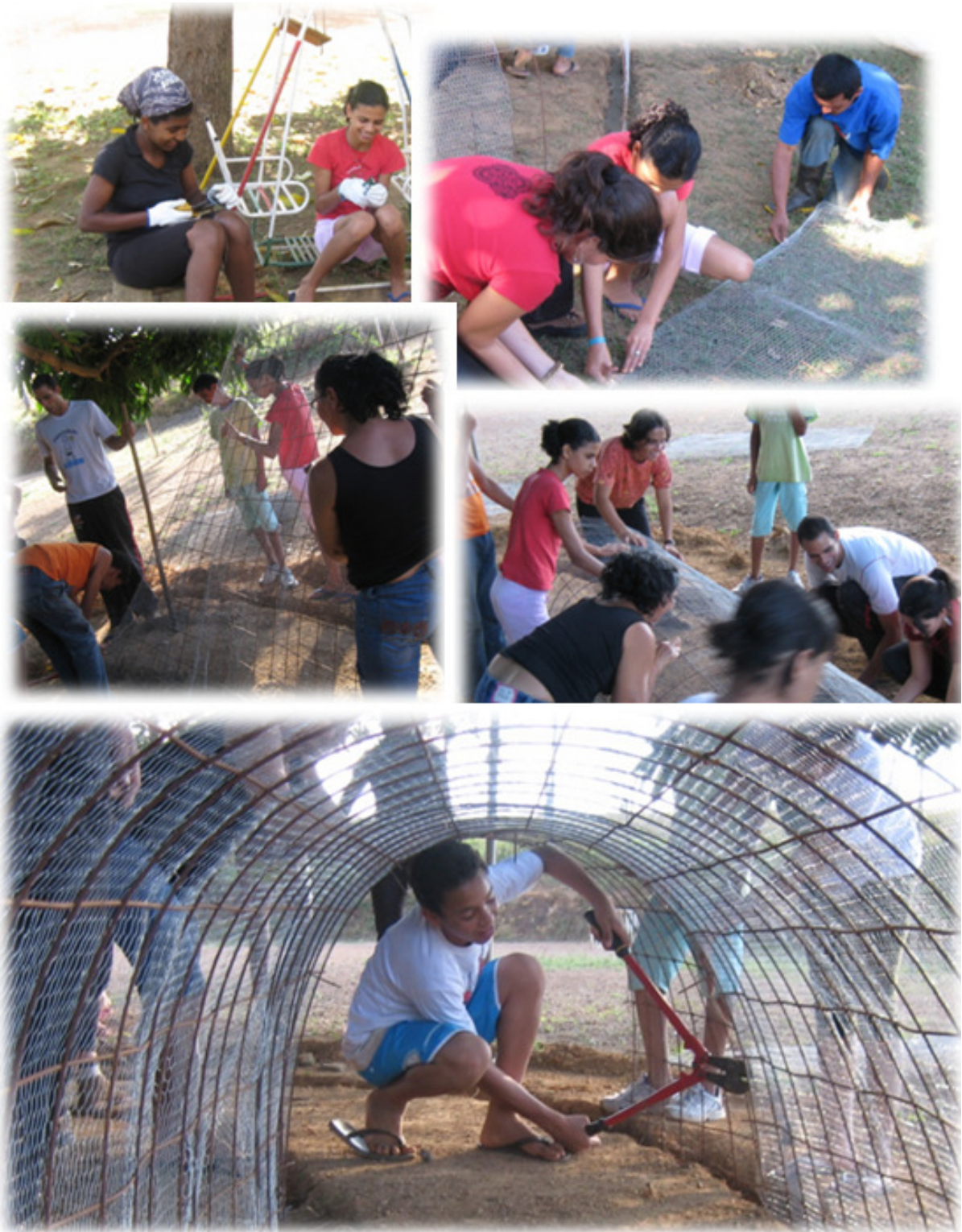
Figura 20 - Estruturação do Túnel
