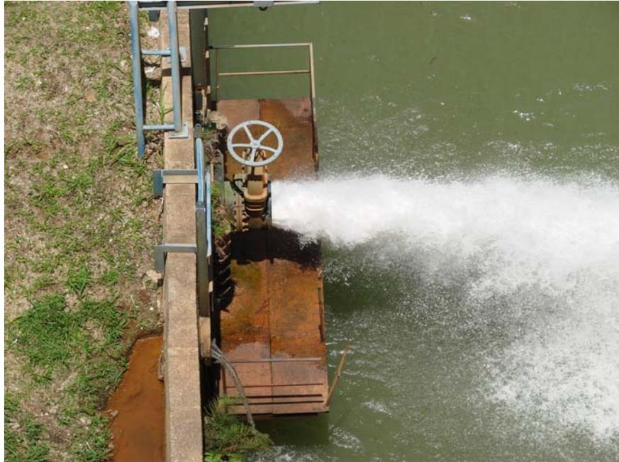
Figura 5.9: Descarga de fundo da barragem do rio Descoberto<sup>3</sup>
