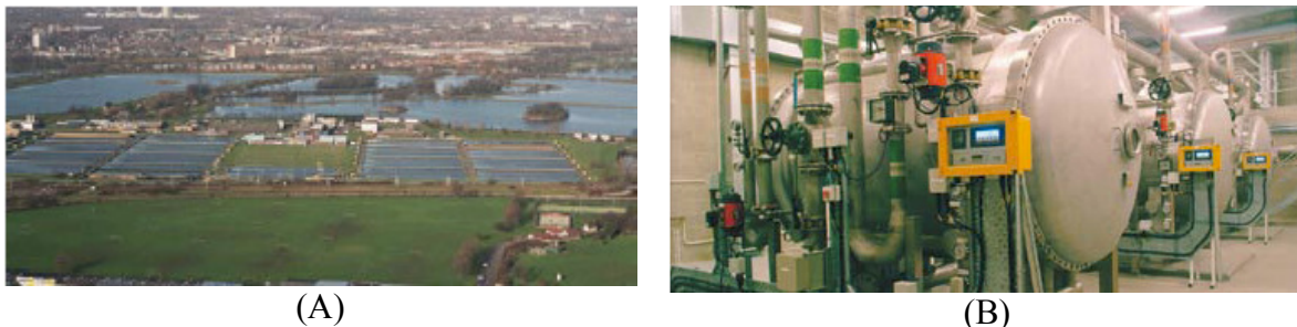
Figura 3.6: Estação de Tratamento de Água Coppermills, Londres, Inglaterra (A) Visão aérea, (B) tanques de ozonização (Thames Water Utilities Ltda, 2006)
