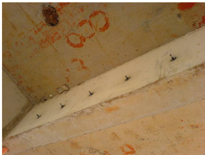
Figura 3-26 Aplicação em obra
