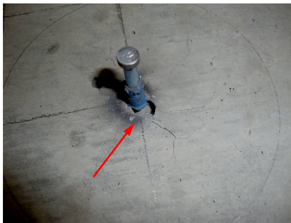
Figura 4-11 Penetração de pino sobre vazio
