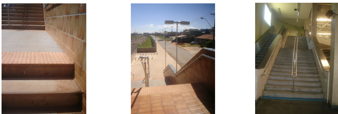
Ilustração 25 – Fotos das escadas da Estação de Metrô Terminal Ceilândia com e sem a sinalização adequada.
