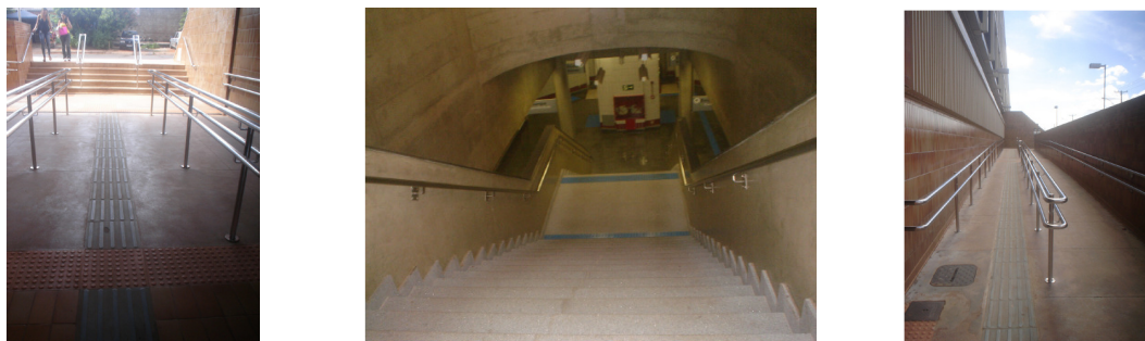
Ilustração 28 – Fotos dos corrimãos e guarda-corpos da Estação de Metrô Guariroba.
