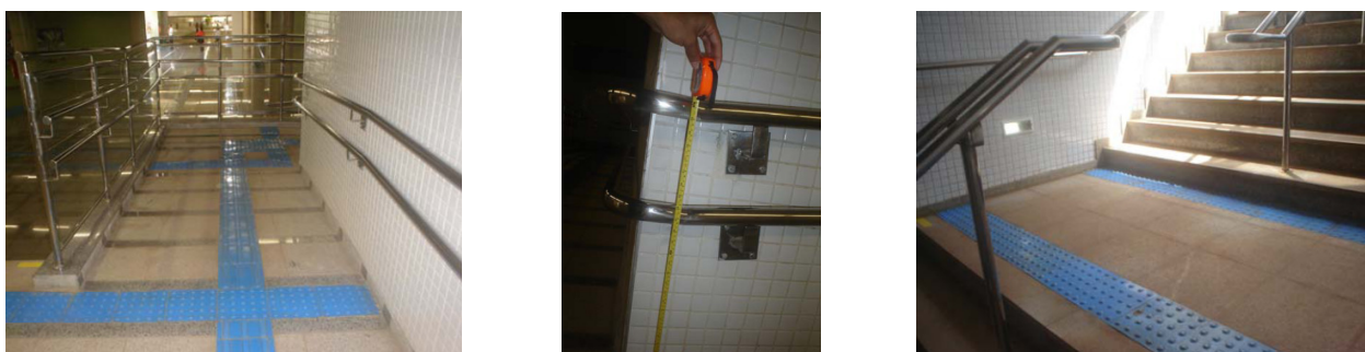
Ilustração 27 – Fotos dos corrimãos e guarda-corpos da Estação de Metrô 108 Sul.
