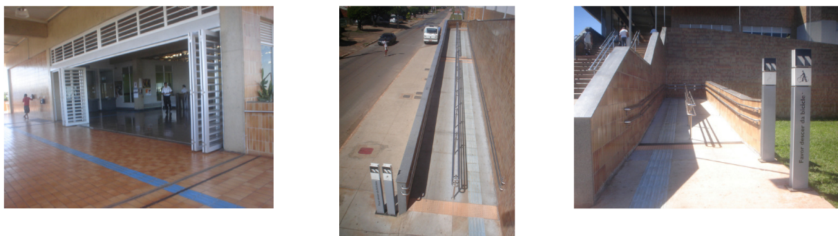
Ilustração 16 – Fotos dos acessos da Estação de Metrô Terminal Ceilândia sem a sinalização recomendada pela norma técnica.
