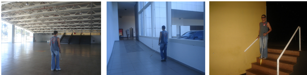
Ilustração 80 – Fotos dos espaços sem a sinalização tátil no piso e extensão incorreta do corrimão, passeio acompanhado com João no Centro de Convenções.
