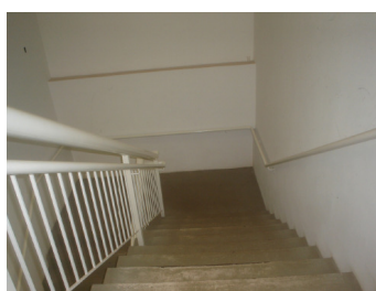
Ilustração 59 – Fotos das escadas fixas do Centro de Convenções sem a sinalização recomendada pela norma técnica.
