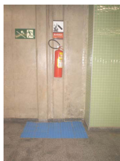
Ilustração 17 – Fotos dos obstáculos suspensos (extintores e orelhões) na Estação de Metrô 108 Sul com e sem sinalização de piso.
