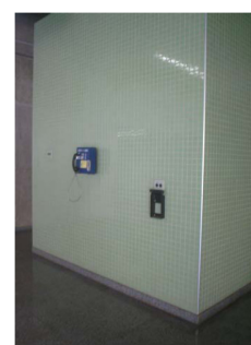
Ilustração 17 – Fotos dos obstáculos suspensos (extintores e orelhões) na Estação de Metrô 108 Sul com e sem sinalização de piso.
