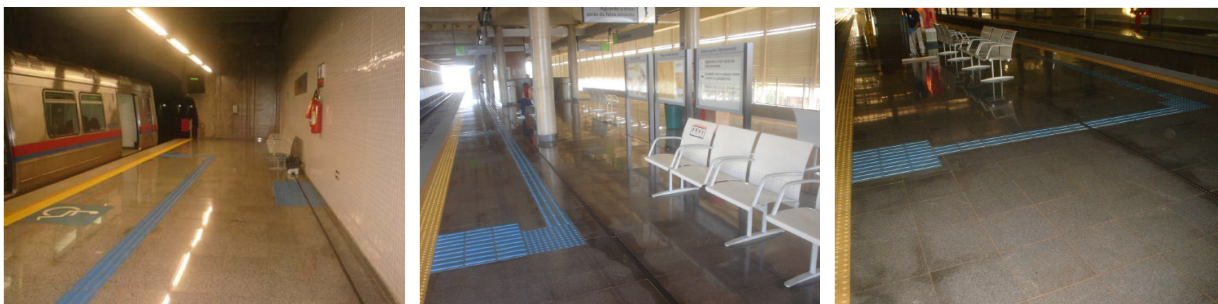
Ilustração 43 – Fotos das sinalizações de posicionamento de pessoas com deficiência visual e física nas plataformas de embarque com piso tátil direcional e de alerta, nas estações de metrô 108 Sul, Guariroba, e Terminal Ceilândia, respectivamente.
