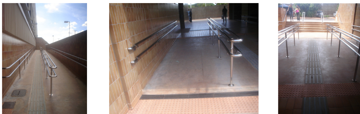
Ilustração 34 – Fotos das rampas da Estação de Metrô Guariroba sinalizadas com pisos táteis de alerta e direcional.
