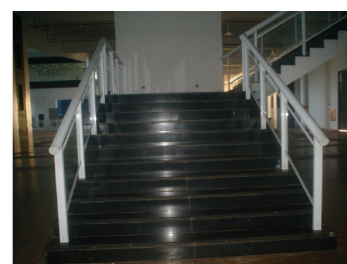
Ilustração 59 – Fotos das escadas fixas do Centro de Convenções sem a sinalização recomendada pela norma técnica.
