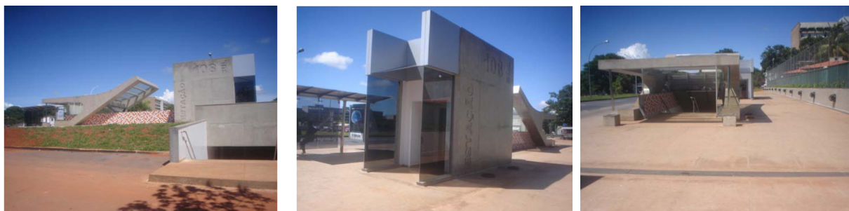
Ilustração 14 – Fotos dos acessos da Estação de Metrô 108 Sul sem a sinalização recomendada pela norma técnica.
