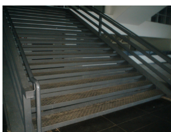
Ilustração 59 – Fotos das escadas fixas do Centro de Convenções sem a sinalização recomendada pela norma técnica.
