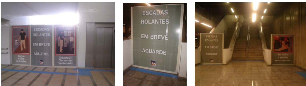
Ilustração 36 – Fotos dos locais reservados para instalação de escadas rolantes na Estação de Metrô 108 Sul.
