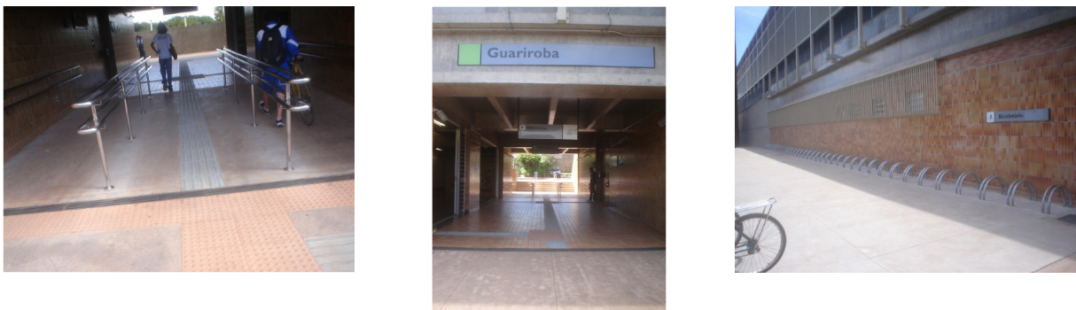
Ilustração 15 – Fotos dos acessos da Estação de Metrô Guariroba sem a sinalização recomendada pela norma técnica.
