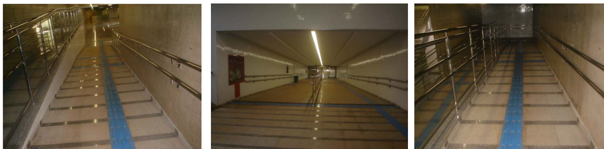
Ilustração 33 – Fotos das rampas da Estação de Metrô 108 Sul sinalizadas com pisos táteis de alerta e direcional.
