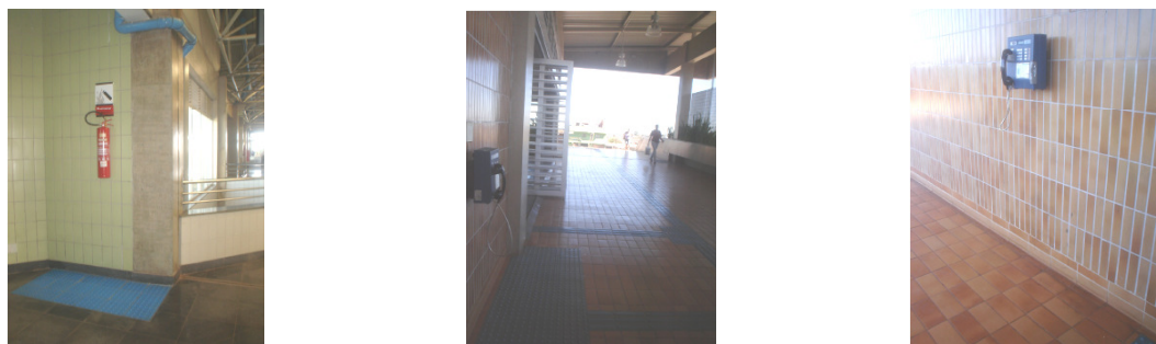
Ilustração 19 – Fotos dos obstáculos suspensos (extintores e orelhões) na Estação de Metrô Terminal Ceilândia com e sem sinalização de piso.
