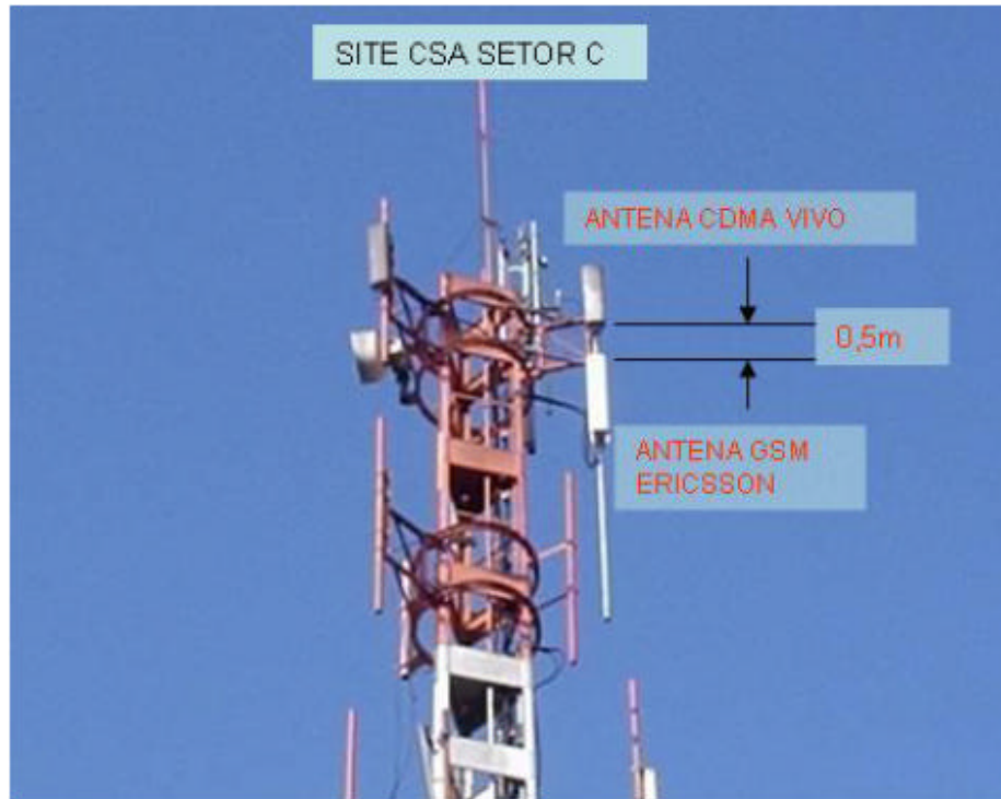
Figura 34 - Testes de Isolação entre Sistemas
