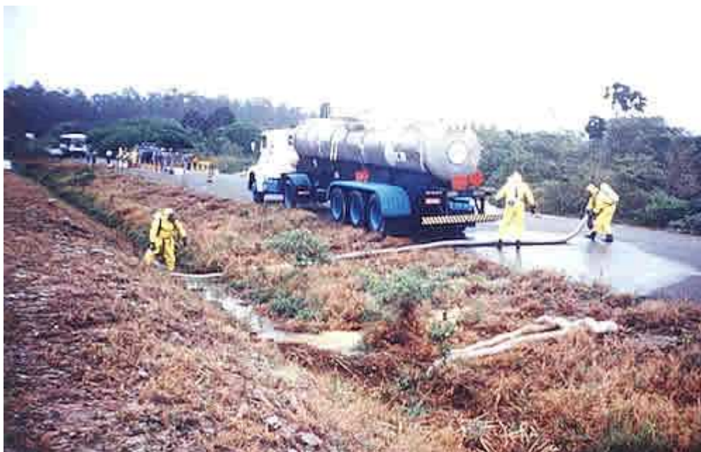
Figura 4 – Operação de Contenção e Recolhimento do Produto Vazado
