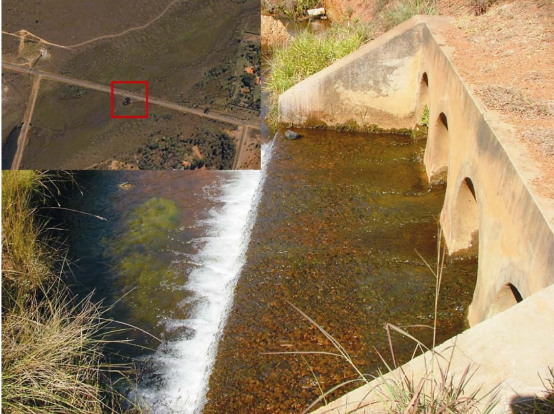
Figura 4 – Edificação em concreto cortando o Córrego do Cedro e no canto superior esquerda a vista aérea da região. Ponto 2.
