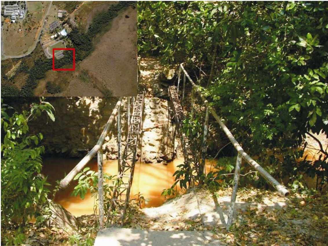
Figura 7 – Ribeirão do Gama no ponto 5, água turva denunciou a retirada indiscriminada de água para uso na obra próximo após o ponto 4. No canto superior esquerdo a vista aérea da região.
