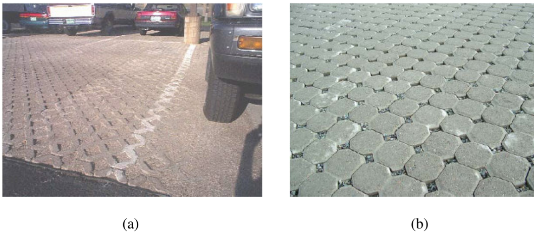
Figura 2.5 – Revestimentos permeáveis: (a) blocos modulares vazados (UDFCD, 2002) e (b) blocos modulares maciços (Hinman, 2005).
