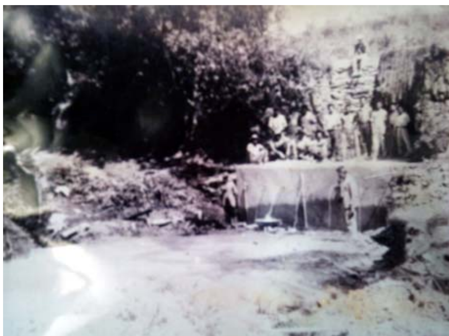
Fig. 35. Início de obras nas Três Bicas. (cerca 1950). Fonte: Acervo Casa da Cultura.
