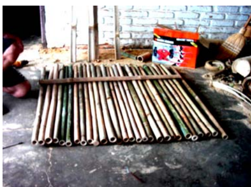
Figura 146 - (a) As travessas de bambu são colocadas por cima e por baixo das varas de preenchimento; (b) Posteriormente, são parafusadas nas varas. (Fonte: Foto da autora, tirada durante a etapa de execução, 2005).
