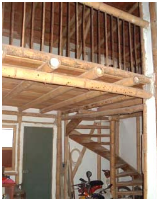
Figura 47 - Laje feita de bambu em edificação de dois pavimentos (Fonte: CR-Rom cedido por Roberto Magno)
