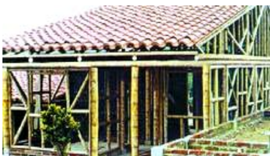
Figura 75 - Casa popular de bambu desenvolvida pelo Projeto Inbambu, Maceió, Alagoas, Brasil (INSTITUTO DO BAMBU, em: www.institutodobambu.org.br ).
