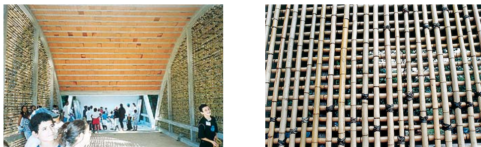
Figura 83 - (a) Pavilhão do Menino Pescador, Centro Cultural O Menino e o Mar, Ubatuba – SP, Arqº Ruy Otake ; (b) Detalhe do painel de bambu trançado, utilizado como vedação. (Fonte: ARCOWEB, em www.arcoweb.com.br ).
