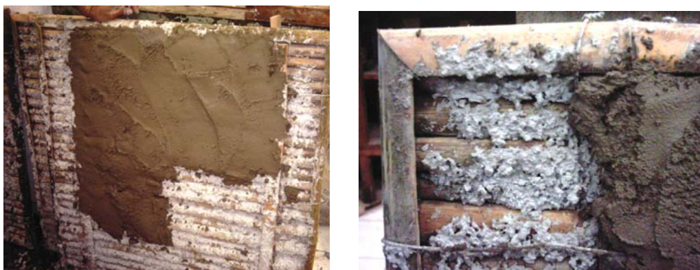
Figura 161 - (a) Argamassa sendo aplicada nas estruturas de bambu; (b) Apenas a moldura de bambu deve ficar aparente. (Fonte: Foto da autora, 2005).
