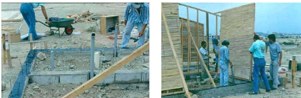
Figura 104 - (a) Preparação da fundação com previsão dos pontos hidráulicos; (b) Fixação dos painéis na fundação. (Fonte: Foto de Luis Fernando Botero, Equador, 2005).
