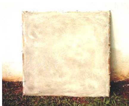
Figura 164 - Aspecto geral do painel revestido com argamassa. ( Fonte: Foto da autora, 2005)
