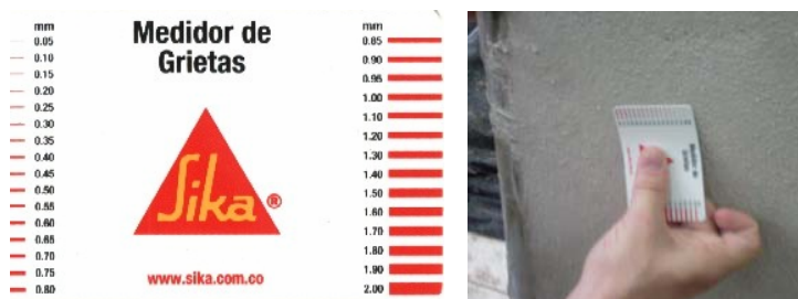
Figura 168 - (a) Fissurômetro utilizado para medir as fissuras dos painéis; (b) Utilização do fissurômetro medindo a abertura superficial das fissuras. (Fonte: Foto da autora, 2005)
