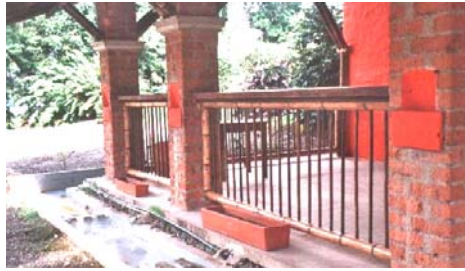
Figura 61 - Guarda corpo de bambu. (Fonte: Foto da autora, Colômbia, dezembro de 2005).
