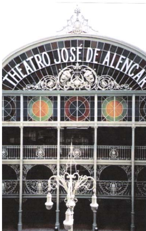
Figura 1 - Fachada em ferro fundido do Teatro José de Alencar, em Fortaleza, Ceará (VON KRUGER, 2000, p.46).
