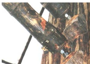
Figura 55 - Conexões das peças de bambu através do parafusamento (VÉLEZ, 2002).
