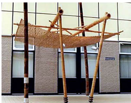
Figura 63 - Marquise de bambu suspensa, compondo fachadas. (Fonte: CD-Rom cedido por Roberto Magno)
