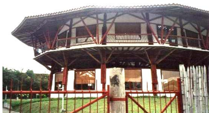
Figura 41 - Edifício sede da CARDER, Corporación Autónoma de Risalda, com 6.524 m 2 construídos de guadua. Obra do Arq. Simon Vélez. (Fonte: Foto da autora, Colômbia, dezembro de 2005).
