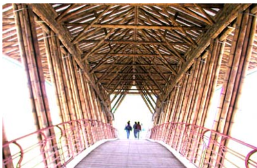
Figura 39 - Ponte de bambu na Colômbia, projeto do Arq. Simón Vélez. (Fonte: Foto de Luis Fernando Botero, 2005).
