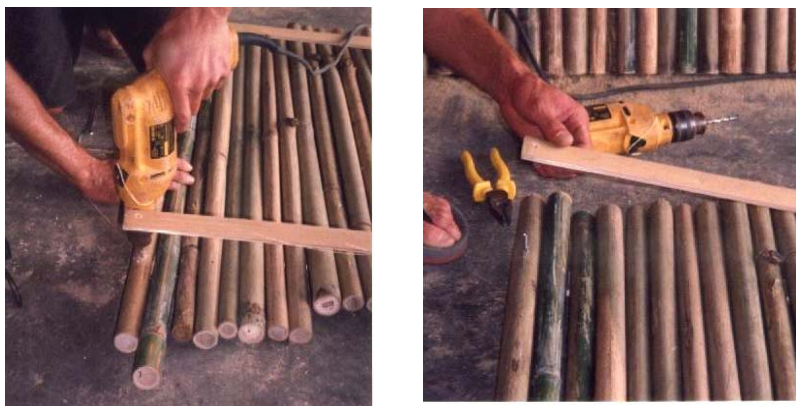
Figura 141 - (a) Fura-se a travessa e o primeiro bambu de preenchimento; (b) faz-se a união com o uso de parafuso e porca. (Fonte: Foto da autora, tirada durante a etapa de execução, 2005).
