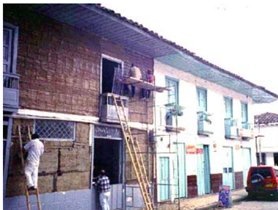
Figura 49 - Painéis de bambu para vedação vertical das habitações. (Fonte: CD-Rom cedido por Luis Fernando Botero)
