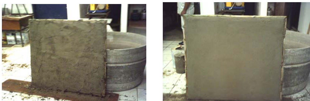
Figura 162 - (a) Estruturas de bambu recobertas pela argamassa de revestimento; (b) Argamassa de revestimento aplainada com régua de madeira. (Fonte: Foto da autora, 2005).
