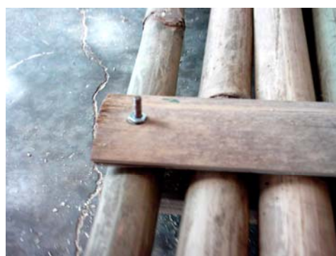
Figura 146 - (a) As travessas de bambu são colocadas por cima e por baixo das varas de preenchimento; (b) Posteriormente, são parafusadas nas varas. (Fonte: Foto da autora, tirada durante a etapa de execução, 2005).
