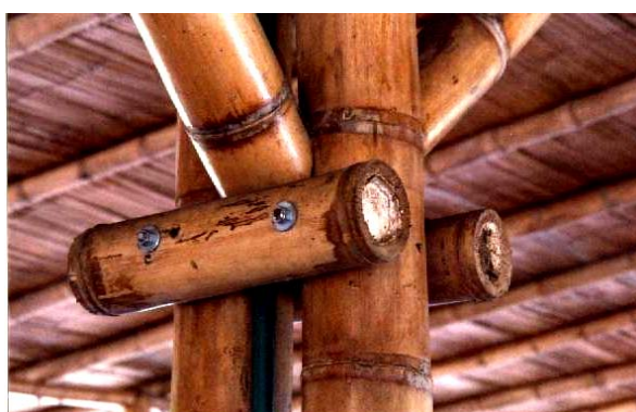
Figura 57 - União de peças de bambu com peças do próprio bambu. (Fonte: Foto da autora, Colômbia, dezembro de 2005).
