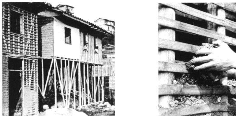
Figura 85 - A estrutura feita de bambu toma forma de parede, sendo posteriormente preenchida com uma mistura de barro e palha (LÓPEZ, 200, p. 239).
