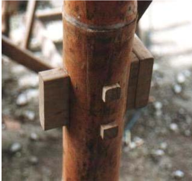
Figura 116 - Tarugo de madeira inserido no pilar de bambu, onde os painéis de bambu posteriormente são fixados. (Fonte: Foto da autora. V Congresso Internacional de Bambu, Costa Rica, 1998).
