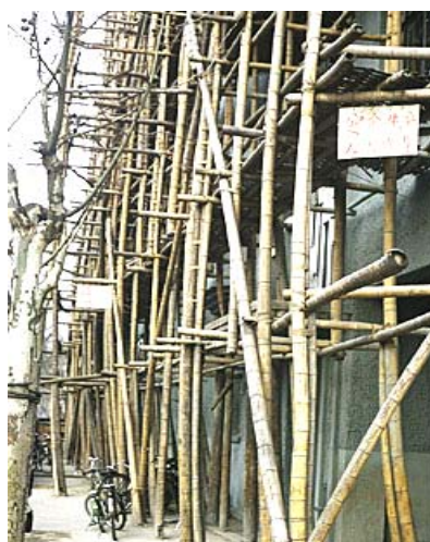
Figura 22 - Bambu utilizado como andaime na China. (Fonte: CD-Rom cedido por Roberto Magno).
