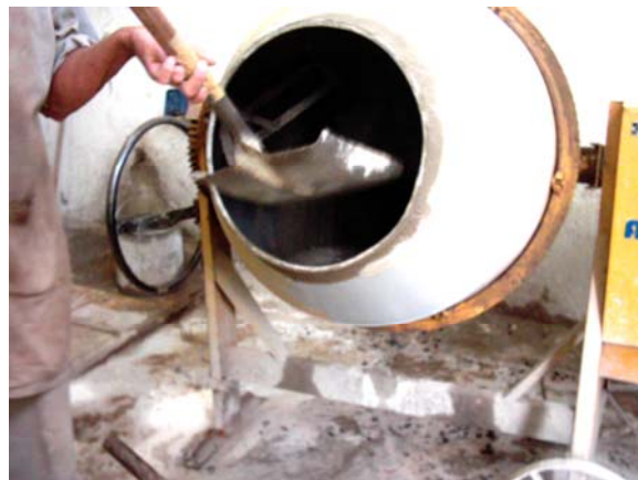
Figura 158 - Preparação da argamassa de chapisco, com o auxílio de betoneira. (Fonte: Foto da autora, 2005).
