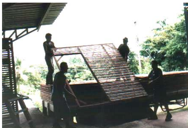
Figura 95 - Transporte dos painéis pré-fabricados. (Fonte: Foto da autora, no V Congresso Internacional de Bambu, San José, Costa Rica, 1998).
