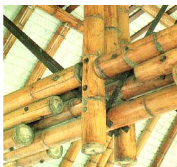
Figura 56 - Conexões das peças de bambu (VÉLEZ, 2002).
