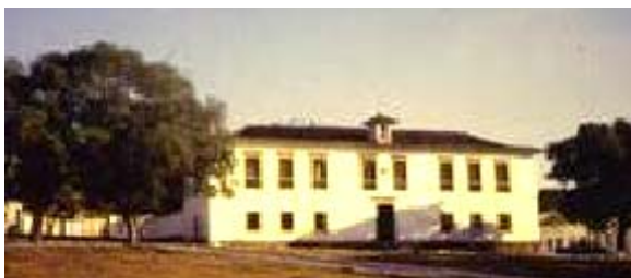
Figura 9 - Construção de terra crua na Cidade de Goiás (BARBOSA, 2005, p.2).
