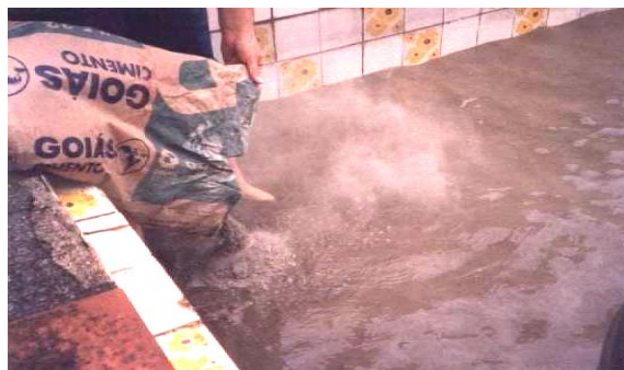
Figura 152 - Calda de cimento sendo preparada no tanque. (Fonte: Foto da autora, tirada durante a etapa de execução, 2005).
