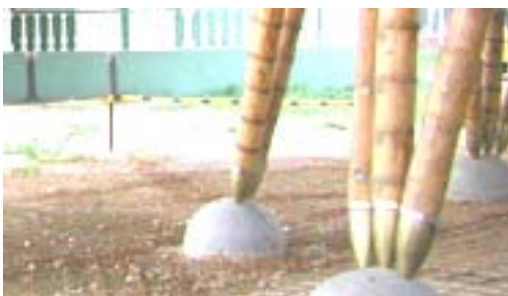
Figura 60 - Detalhe da ligação dos bambus (VÉLEZ, 2002).
