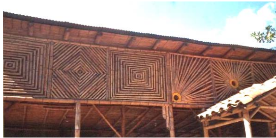
Figura 62 - Fechamento feito com bambus, formando desenhos geométricos. (Fonte: Foto da autora, Colômbia, dezembro de 2005).
