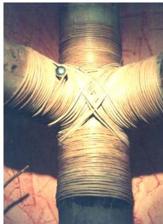
Figura 58 - Detalhe de amarração da conexão de bambu, com fibras naturais. (Fonte: Foto de Ana Maria França, Goiânia, 1997).
