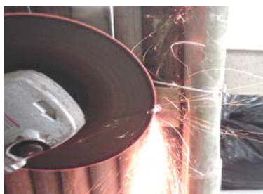
Figura 166 - Remoção de resíduos (nós e parafusos) do painel. (Fonte: Foto da autora, 2005)
