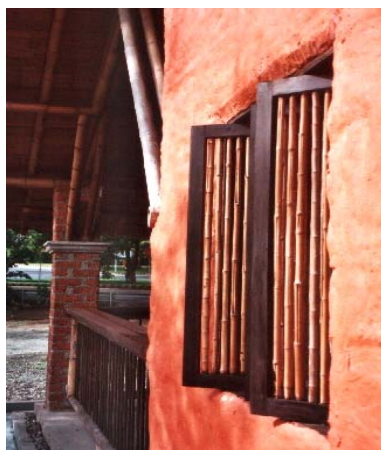
Figura 66 - Esquadria do tipo pivotante, feita de bambu. (Fonte: Foto da autora, Colômbia, dezembro de 2005).
