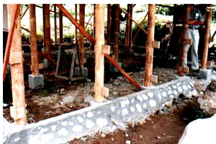
Figura 44 - Pilares de bambu apoiados em bases de concreto. (Fonte: Foto da autora, Costa Rica, 1998).
