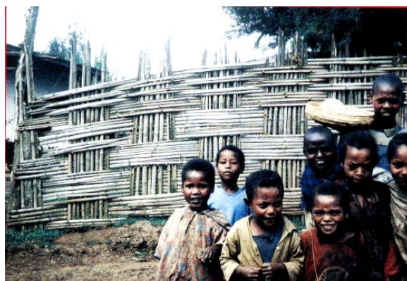
Figura 78 - Painel feito de bambus estacados nos dois sentidos, uma das técnicas mais simples ( VÉLEZ, 2000, p.93).
