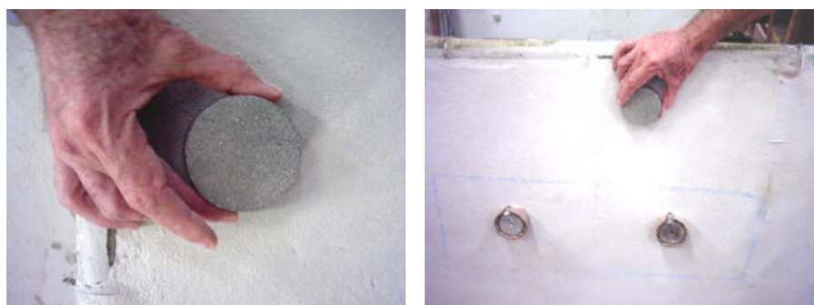
Figura 170 - (a) Pedra abrasiva de “carburundum”; (b) Movimentos circulares feitos sobre a superfície dos painéis argamassados. (Fonte: Foto da autora, 2005)
