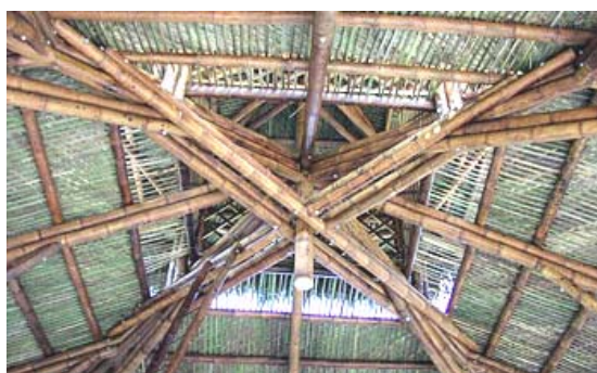
Figura 50 - Estrutura de telhado, tendo o bambu como principal material de construção (VÉLEZ, 2002).
