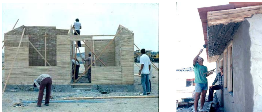
Figura 105 - (a) A casa sendo vedada pelos painéis. (b) Painéis sendo rebocados. (Fonte: Foto de Luis Fernando Botero, 2005).
