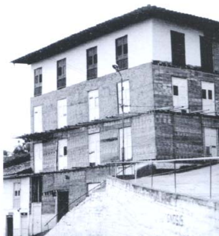
Figura 87 - Esta edificação de quatro pavimentos foi construída por volta de 1930, em Salamina, Colômbia, e somente nos anos setenta as esteiras de bambu foram substituídas e rebocadas (LÓPEZ, 2003, p.240).
