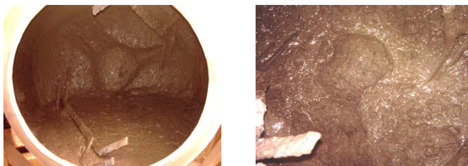
Figura 160 - (a) Preparação da argamassa de revestimento na betoneira; (b) Argamassa pronta para ser projetada às estruturas de bambu. (Fonte: Foto da autora, 2005).
