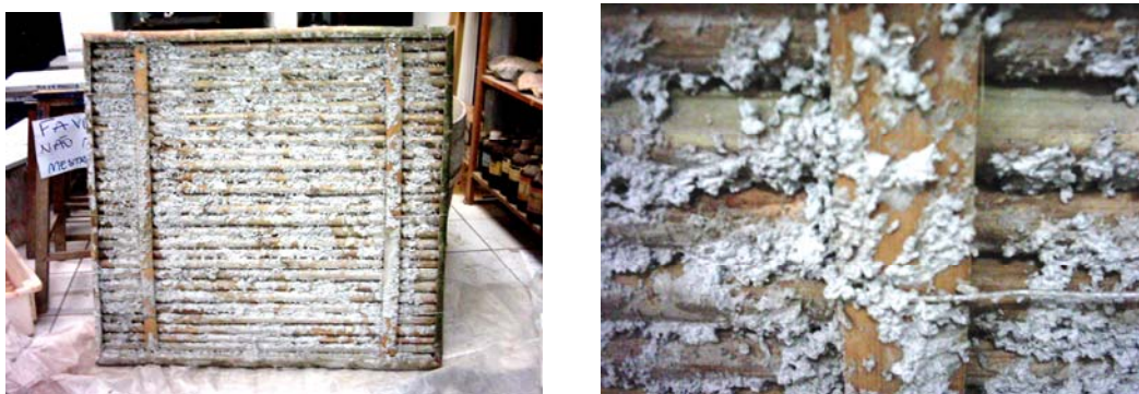
Figura 159 - (a) Estrutura de bambu após a aplicação da argamassa de chapisco; (b) Detalhe da argamassa de chapisco aderida aos bambus. (Fonte: Foto da autora, 2005).
