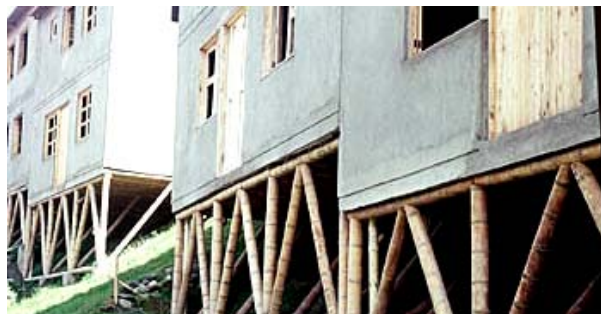
Figura 70 - Paredes cobertas com esteiras de bambu antes do reboco (IL31 BAMBOO, 1992).
