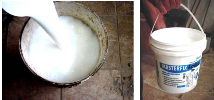
Figura 157 - Galão de adesivo de base acrílica, utilizado na preparação da argamassa de chapisco; (b) Produto sendo misturado na água. (Fonte: Foto da autora, 2005).
