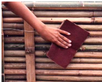
Figura 151 - Lixa grossa para madeira, utilizada para lixar a superfície da estrutura de bambu.
