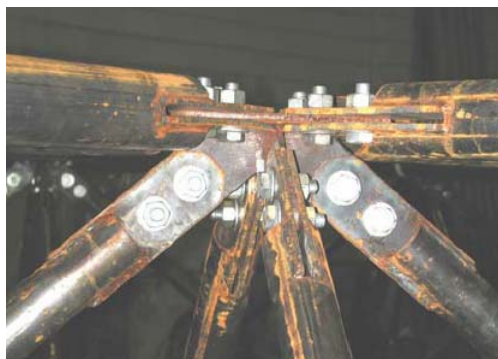
Figura 2.66 – Detalhe da ligação com chapa de ponteira (Souza, 2003)
