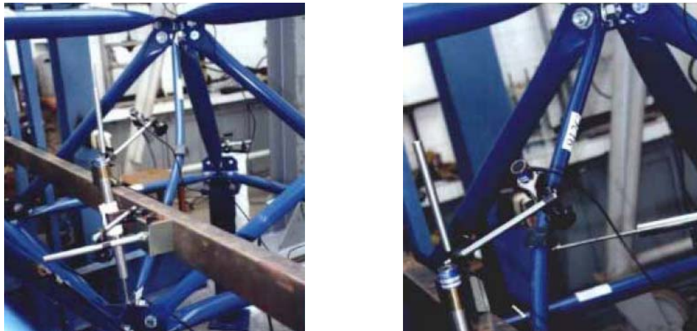
Figura 2.59 – Deformada das barras após colapso por flambagem (Silva, 1999)
