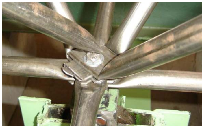
Figura 6.17 – Detalhe da ruptura da diagonal no ensaio do protótipo LTD3
