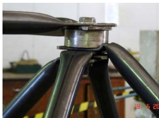
Figura 5.45 – Deformada da ligação com carga de 25kN – Protótipo LTDE2
