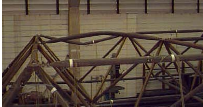
Figura 2.52 – Deformada dos nós após ruína (Maiola, 1999)
