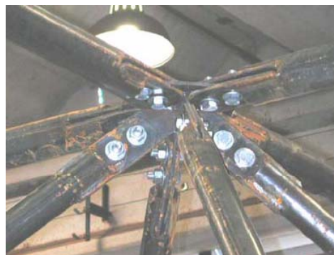
Figura 2.66 – Detalhe da ligação com chapa de ponteira (Souza, 2003)
