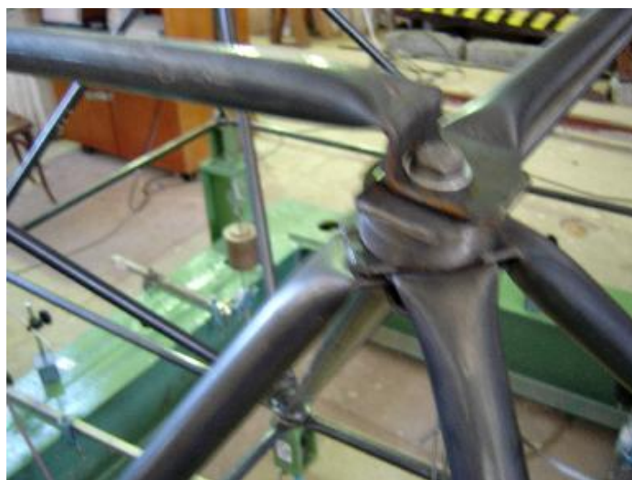
Figura 5.51 – Colapso global da estrutura com carga de 38kN – Protótipo LTDE1
