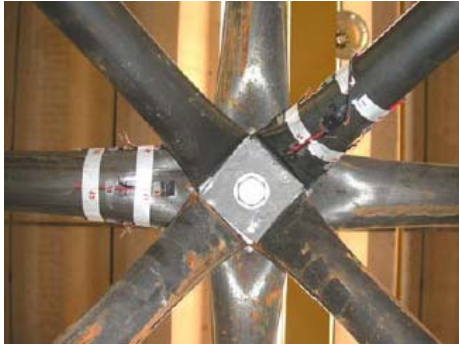
Figura 2.63 – Detalhe da ligação com nó típico (Souza, 2003)
