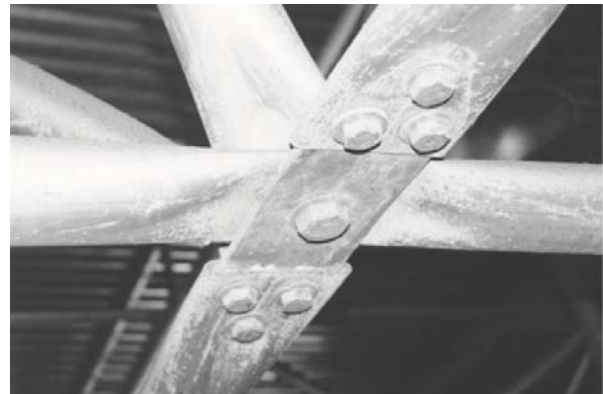
Figura 2.33 – Ligação com nó típico e chapa complementar (Souza, 2003)
