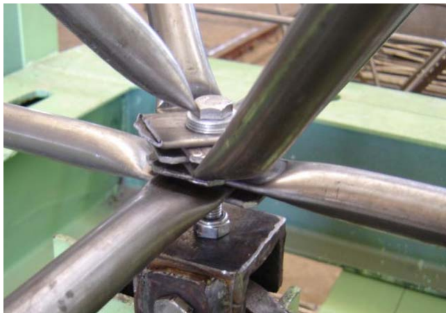
Figura 6.18 – Detalhe da ruptura da diagonal no ensaio do protótipo LTD4
