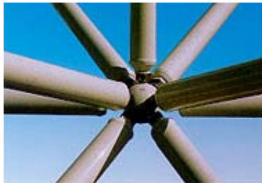
Figura 2.19 – Sistema de ligação ORTZ SYSTEM – Inglaterra (www.lanik.com)
