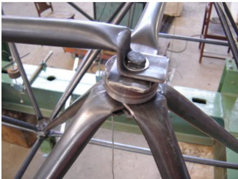
Figura 5.53 – Colapso global da estrutura com carga de 36kN – Protótipo LTDE3
