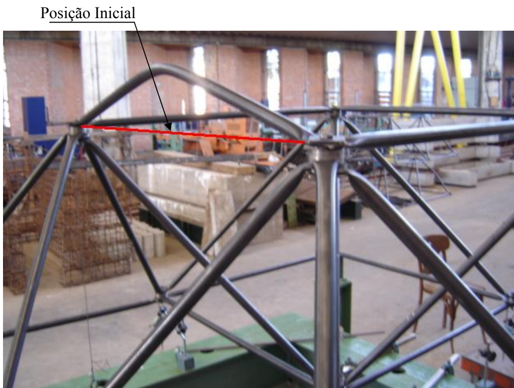
Figura 5.67 – Colapso global da estrutura com carga de 42,4kN – Protótipo LTDCE3
