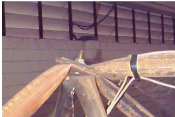
Figura 2.51 – Deformada dos nós após ruína (Maiola, 1999)
