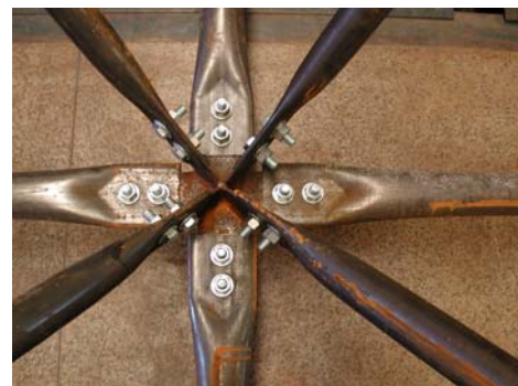
Figura 2.65 – Detalhe da ligação com nó de aço (Souza, 2003)
