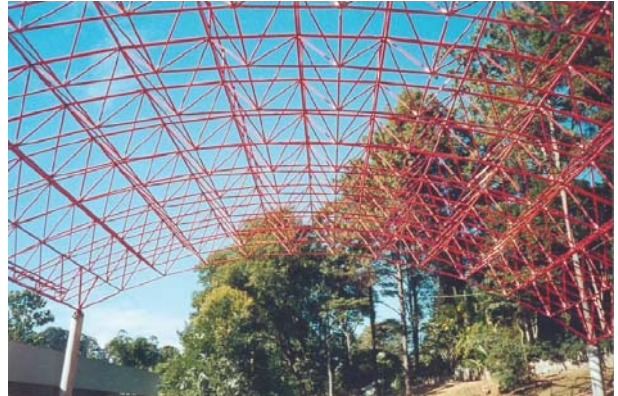
Figura 2.9 – Estrutura espacial em arco
