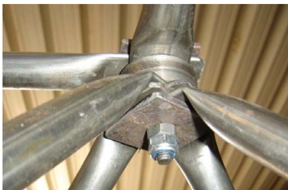
Figura 6.13 – Colocação de contra-porcas de pressão nas ligações
