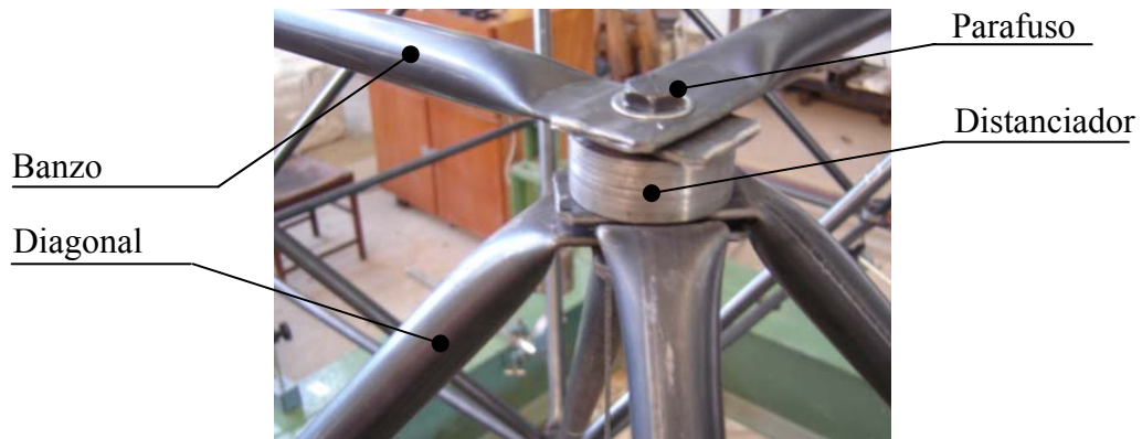
Figura 5.20 – Ligação típica com distanciador – LTDE
