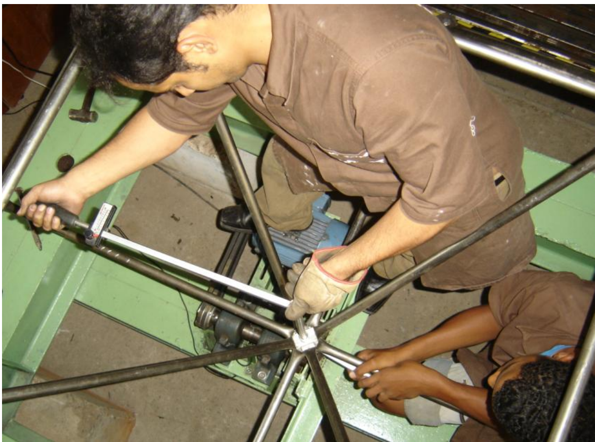
Figura 6.12 – Aperto dos parafusos com torquímetro
