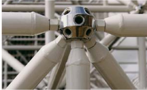
Figura 2.31 – Sistema de ligação ALUAÇO SPACE ( www.aluaco.com.br )
