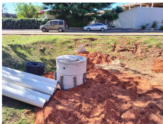
Figura 4.30: Poço de infiltração - configuração final antes de soterramento.
