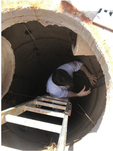
Figura 4.32: Poço de infiltração - detalhe da instalação da régua linimétrica.
