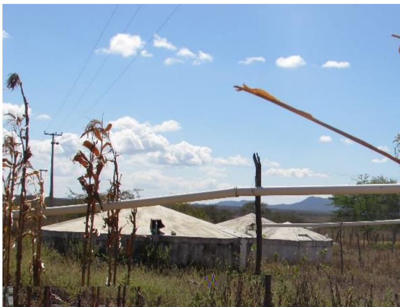
Figura 45 - Cisterna de placa
