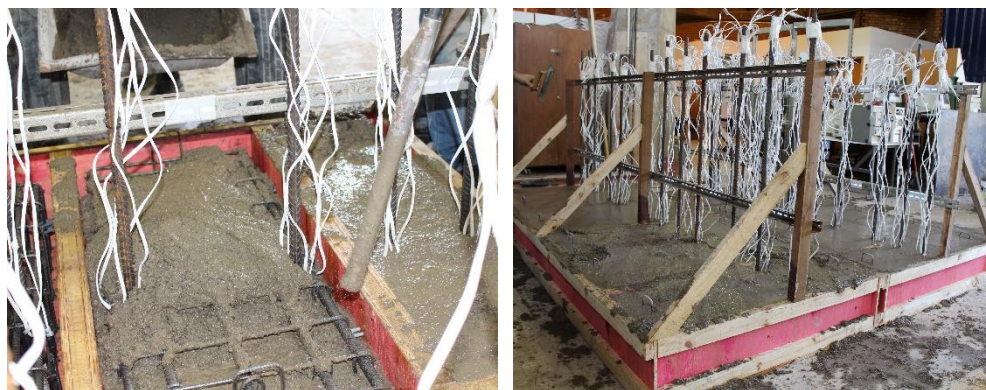
Figura 3.11 - Concretagem da segunda série de ensaios
